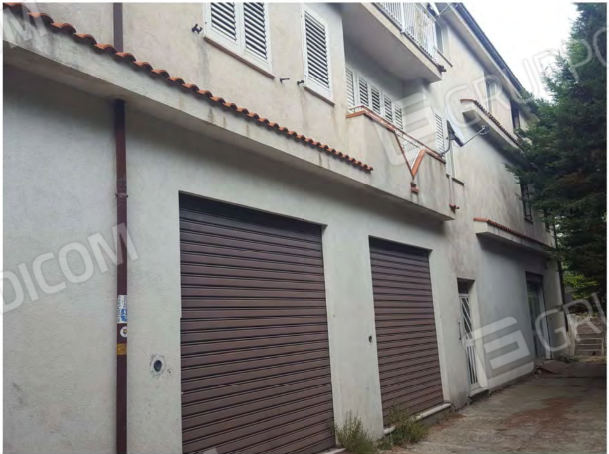
Prospetto sud del fabbricato di ubicazione del bene
