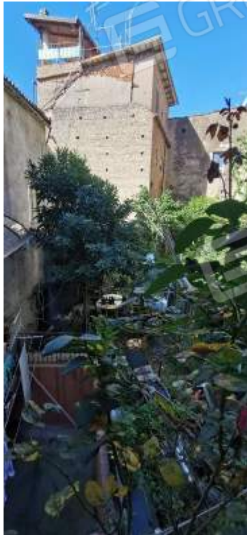
Foto 3: Vista della corte di proprietà esclusiva - in basso a sinistra vasca di espansione acque meteoriche sistema fognario comunale.
