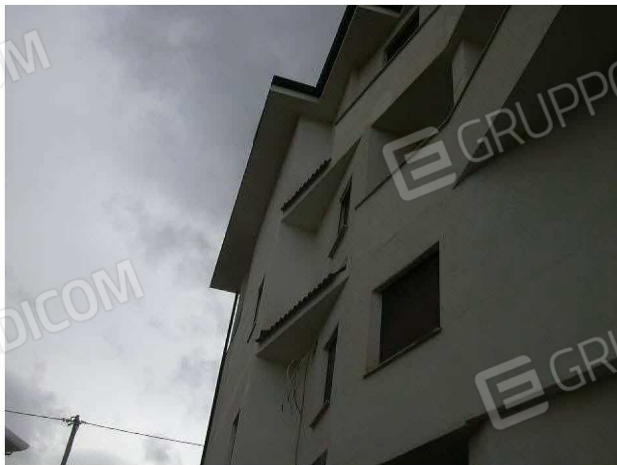
VISTA ESTERNA LATO EST
