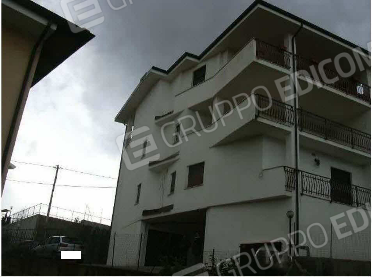
VISTA ESTERNA LATO EST
