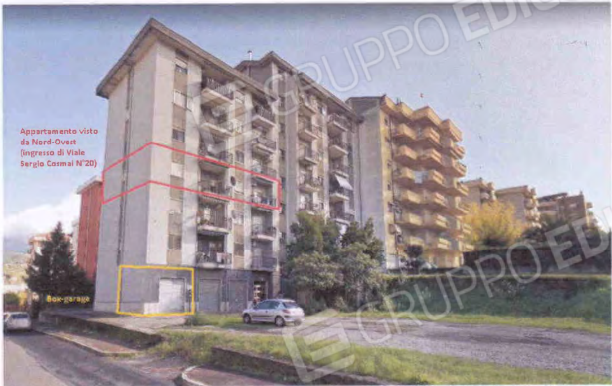
Vista dell'EDIFICIO da Nord-Ovest con individuazione degli IMMOBILI in questione.
