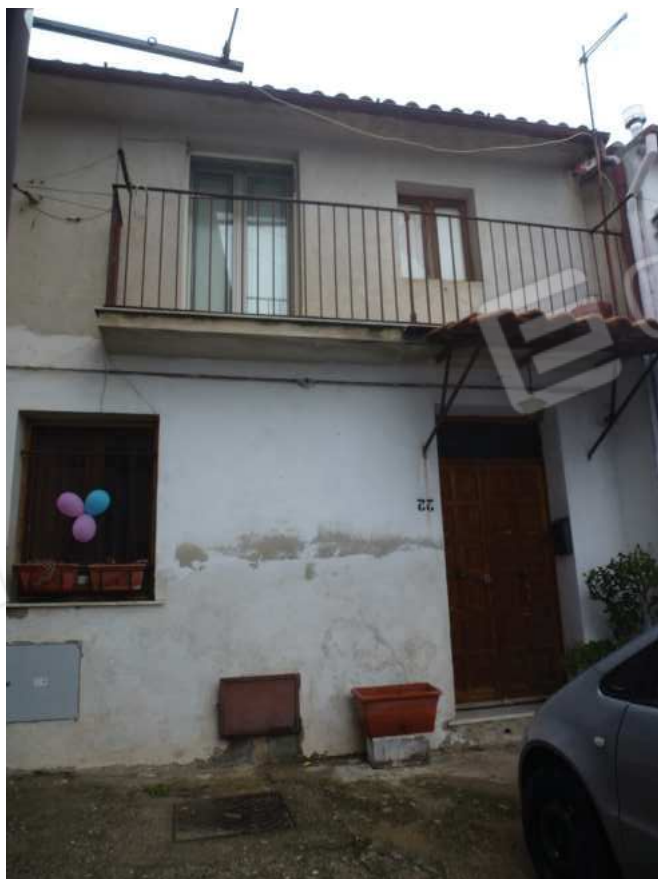
Foto 1 - Prospetto lato Ovest
