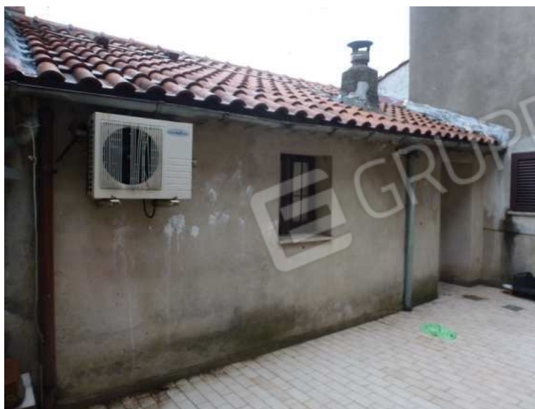
Foto 4 - Prospetto lato Est (retro)
