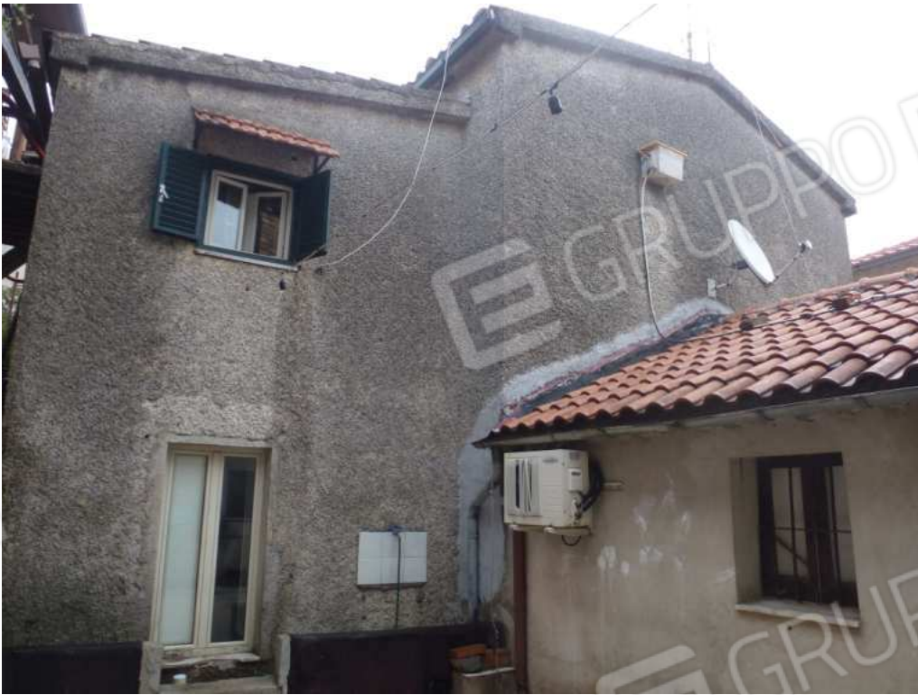
Foto 5 - Prospetto lato Sud (retro)
