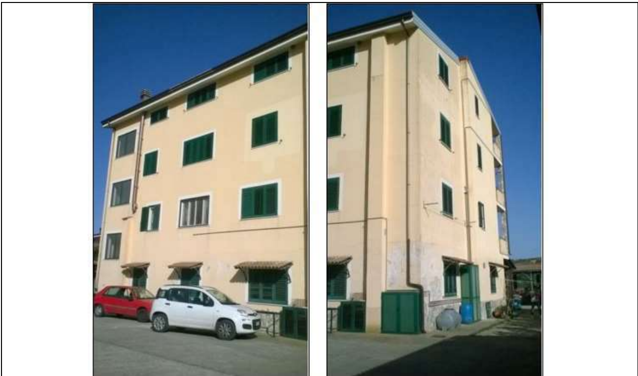
Fig. 4 – Immagini dell'esterno del fabbricato
