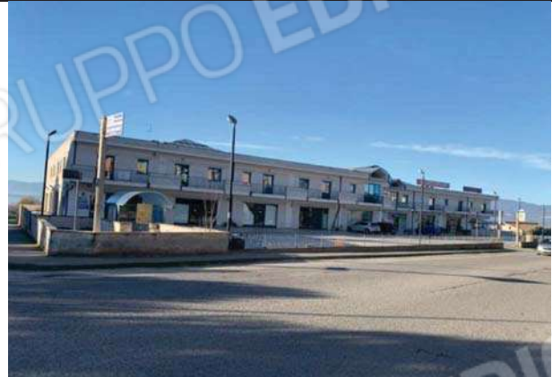
Vista generale del compendio da Corso d'Italia
