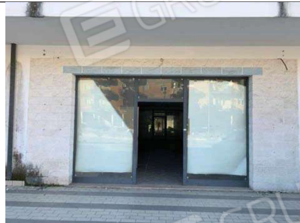
Vista dell'accesso dalla corte esterna
