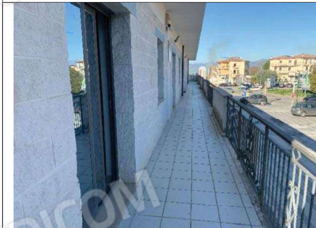
Vista terzo locale dell'ufficio/studio - balcone
