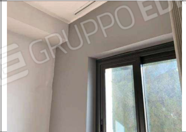
Vista primo locale dell'ufficio/studio – infisso esterno
