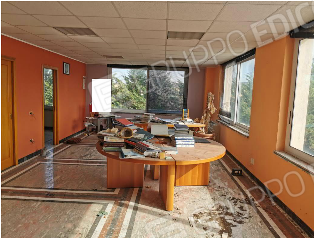
Foto 11: interno zona uffici piano primo. Fg. 29 P.IIa 196 sub 2
