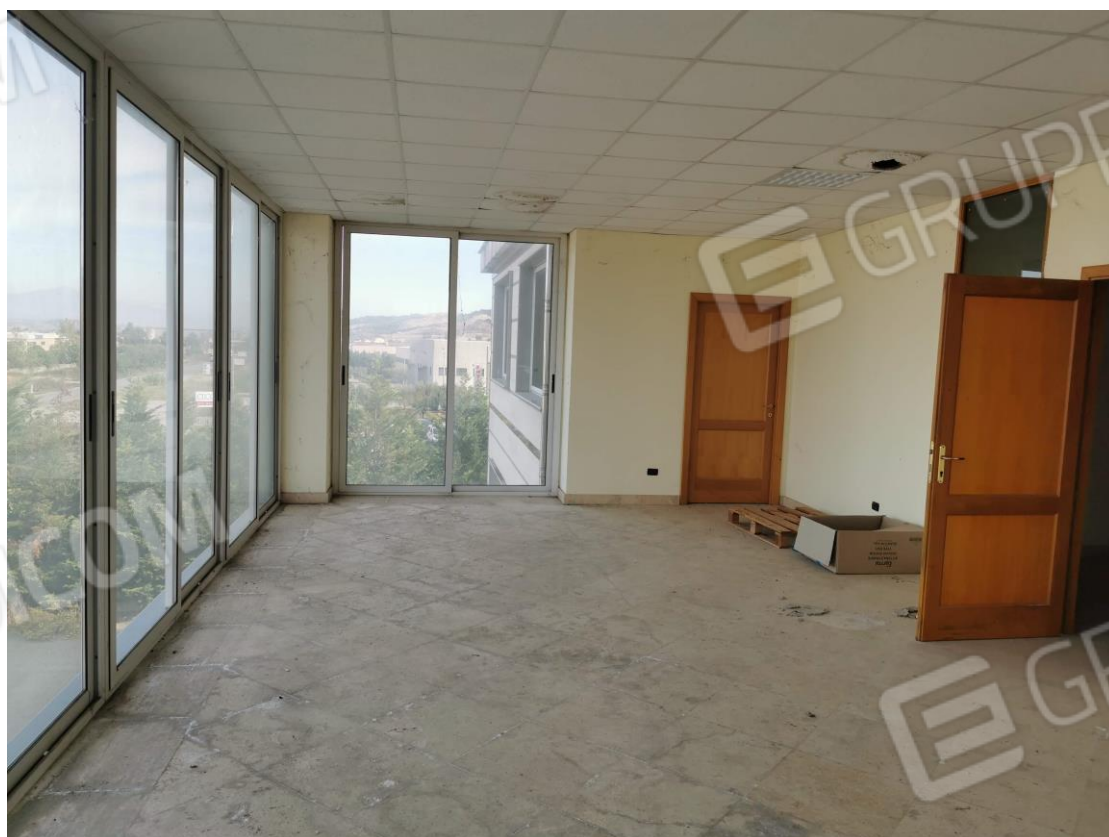
Foto 18: interno piano secondo. Fg. 29 P.Ila 197 sub 9.
