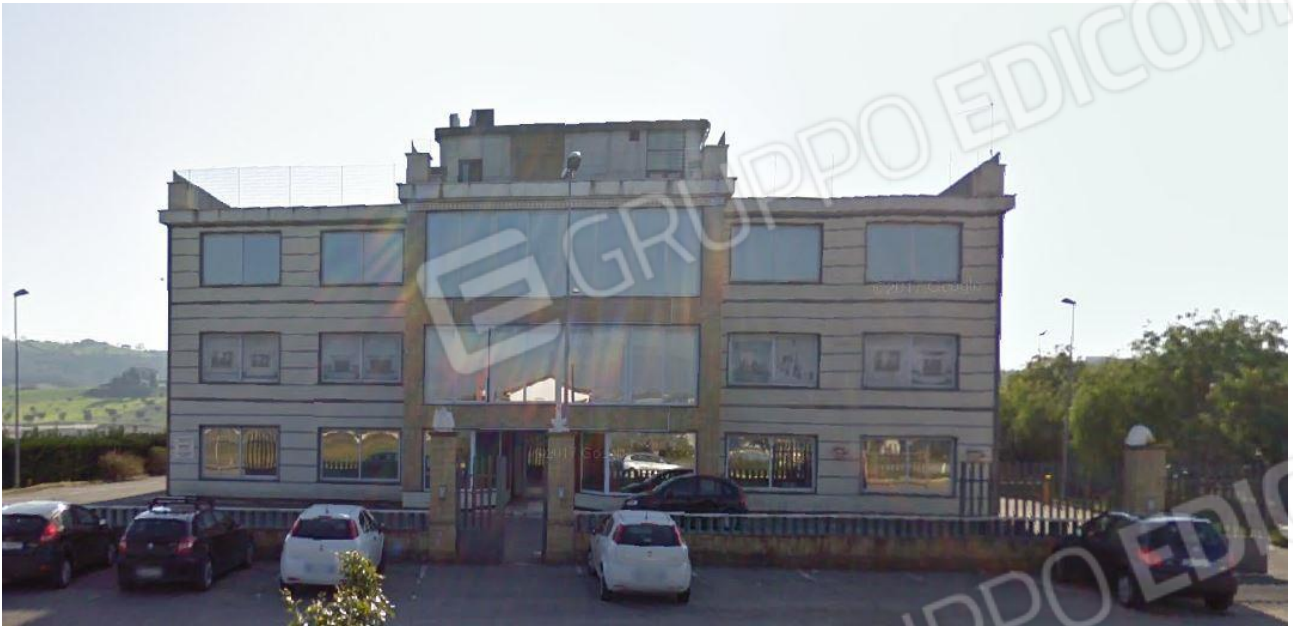
Foto 1: vista esterna ingresso Nord Ovest.
