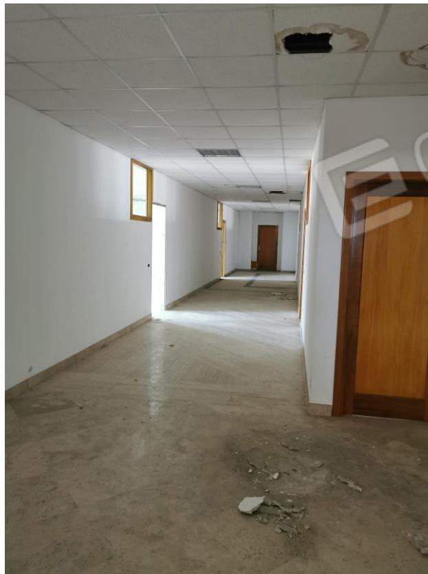
Foto 16: interno piano secondo. Fg. 29 P.Ila 197 sub 12.
