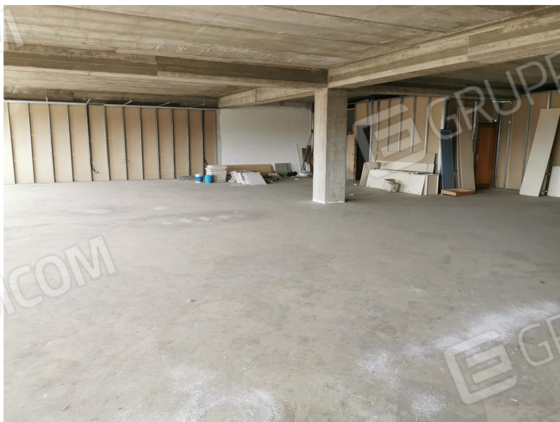
Foto 14: interno piano secondo Fg. 29 P.Ila 197 sub 14
