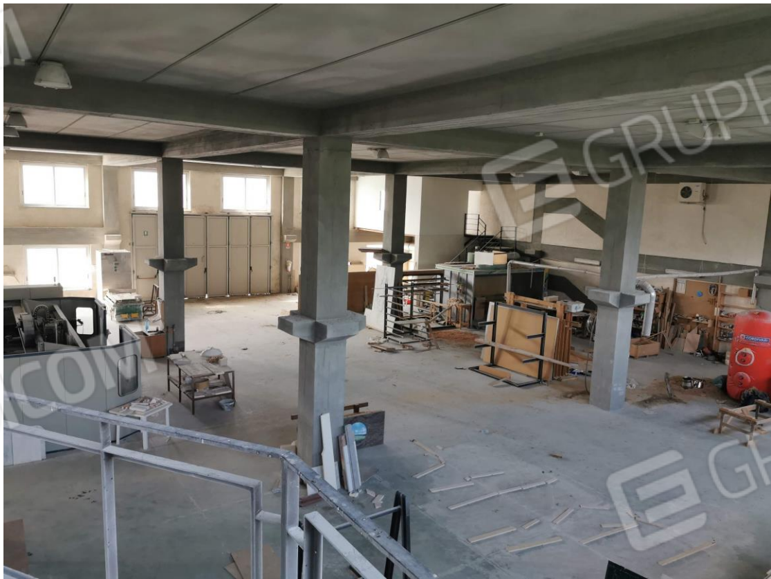
Foto 6: vista interno Fg. 29 P.Ila 197 sub. 14
