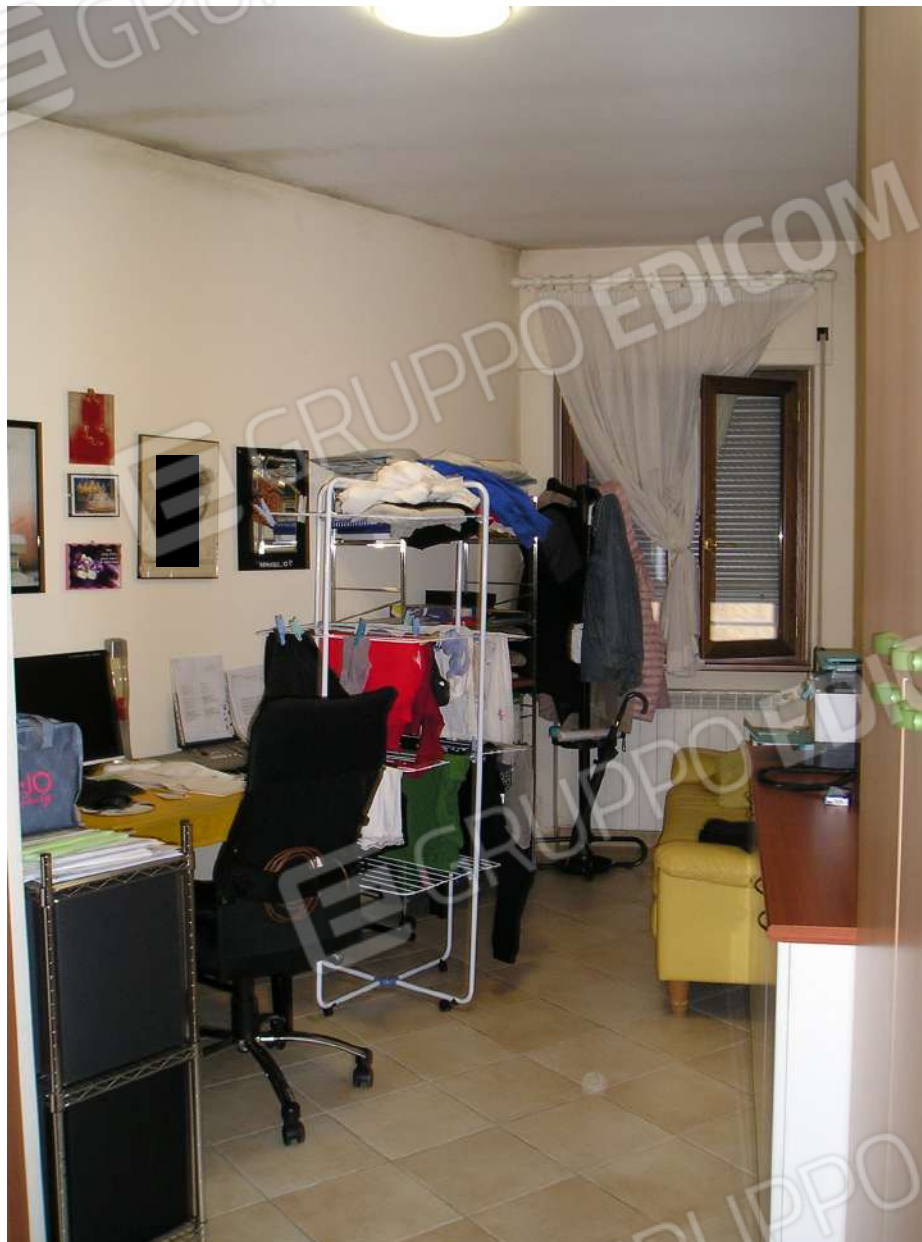
Foto n. 15: Vano adibito a studio con presenza di muffe completamente abusivo
