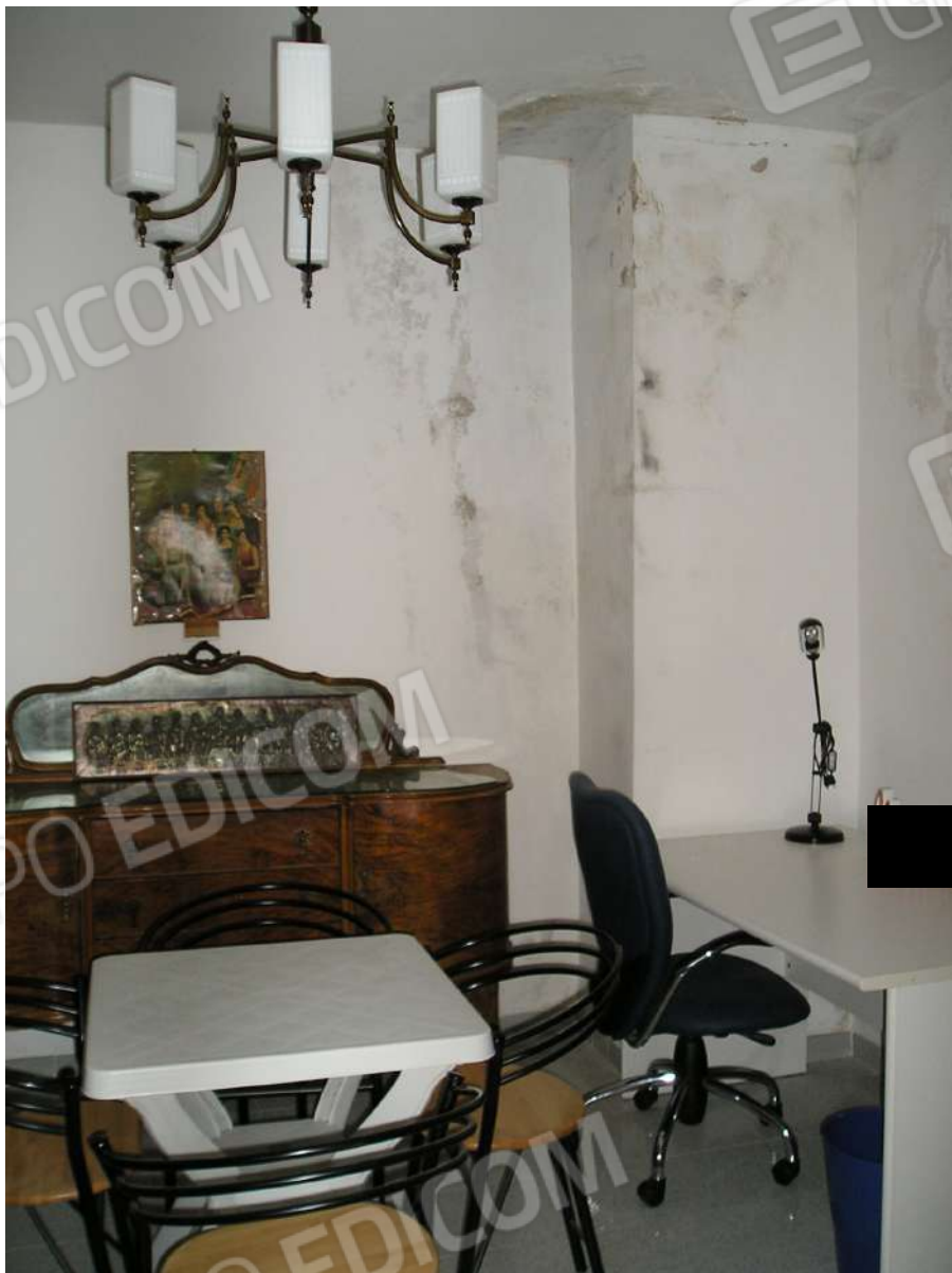
Foto n. 27: Vano pluriuso con presenza di infiltrazioni
