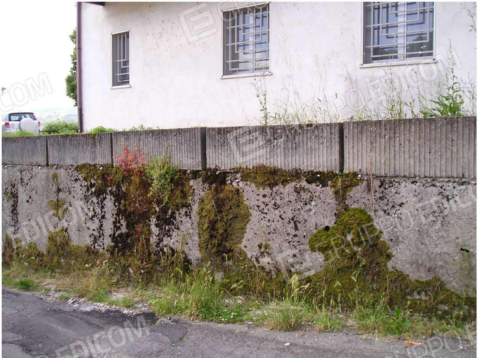
Foto n. 7: Particolare muro a valle del fabbricato
