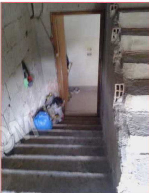
Foto n.21–scale di accesso al sottotetto-1ª rampa
