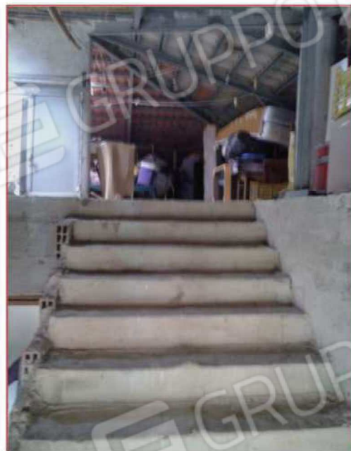
Foto n.22–scale di accesso al sottotetto-2ª rampa
