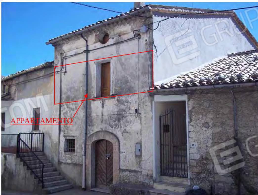
FOTO N° 4 – Altra veduta Appartamento oggetto dell'esecuzione (Piano Primo)
