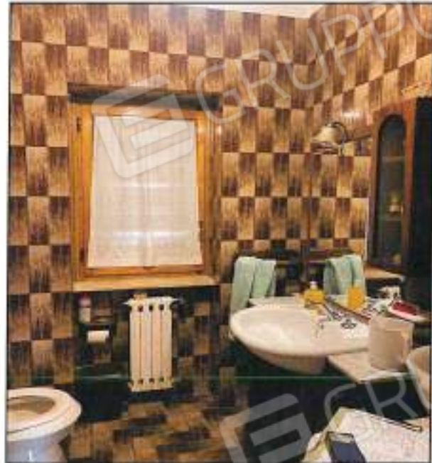
Foto n° 20 – Vista interna locale wc al piano terra/terzato, sono visibili le rifiniture rivestimento a tutta altezza in ceramica dell'epoca di costruzione di buona qualità, riscaldamento con termosifoni.
