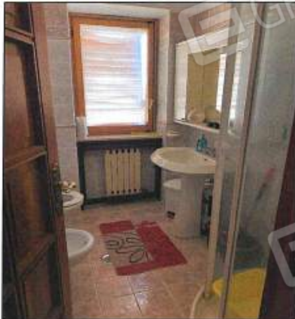
Foto n° 33- Vista interna wc al piano mansardato, rivestimenti in ceramica, radiatori in ghisa.
