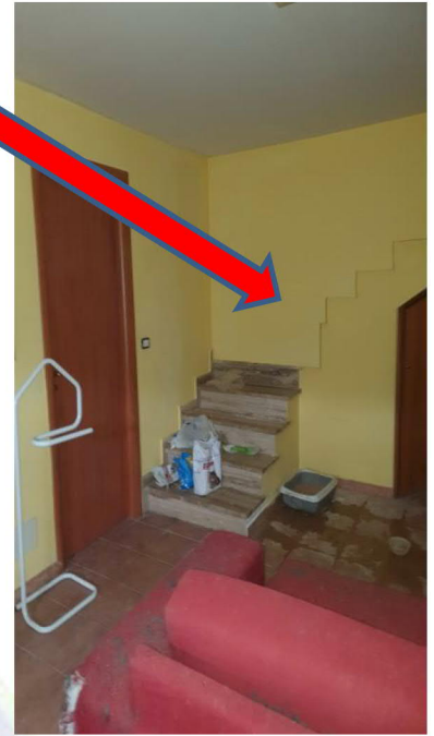
Parete di chiusura vano scala
