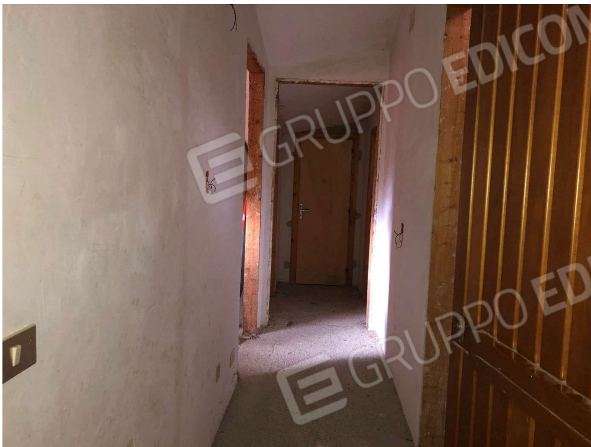
Foto 29 - Corridoio soffitte al piano terso/sottotetto.
