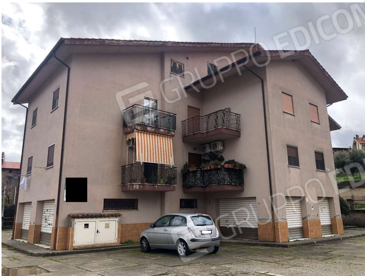
Foto 1 - Fabbricato in Marano Marchesato, Via Morroni n.33.
