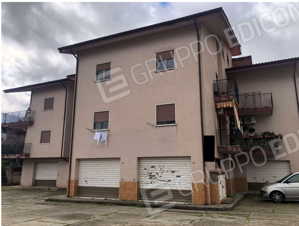
Foto 3 - Fabbricato in Marano Marchesato, Via Morroni n.33.
