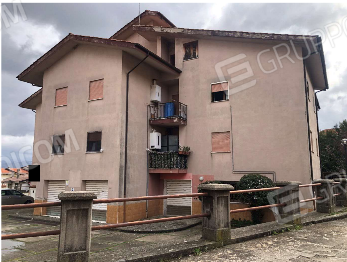
Foto 2 - Fabbricato in Marano Marchesato, Via Morroni n.33.
