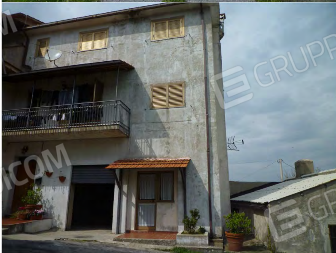
FOTO 7-8 strada comunale e part.lla 232
