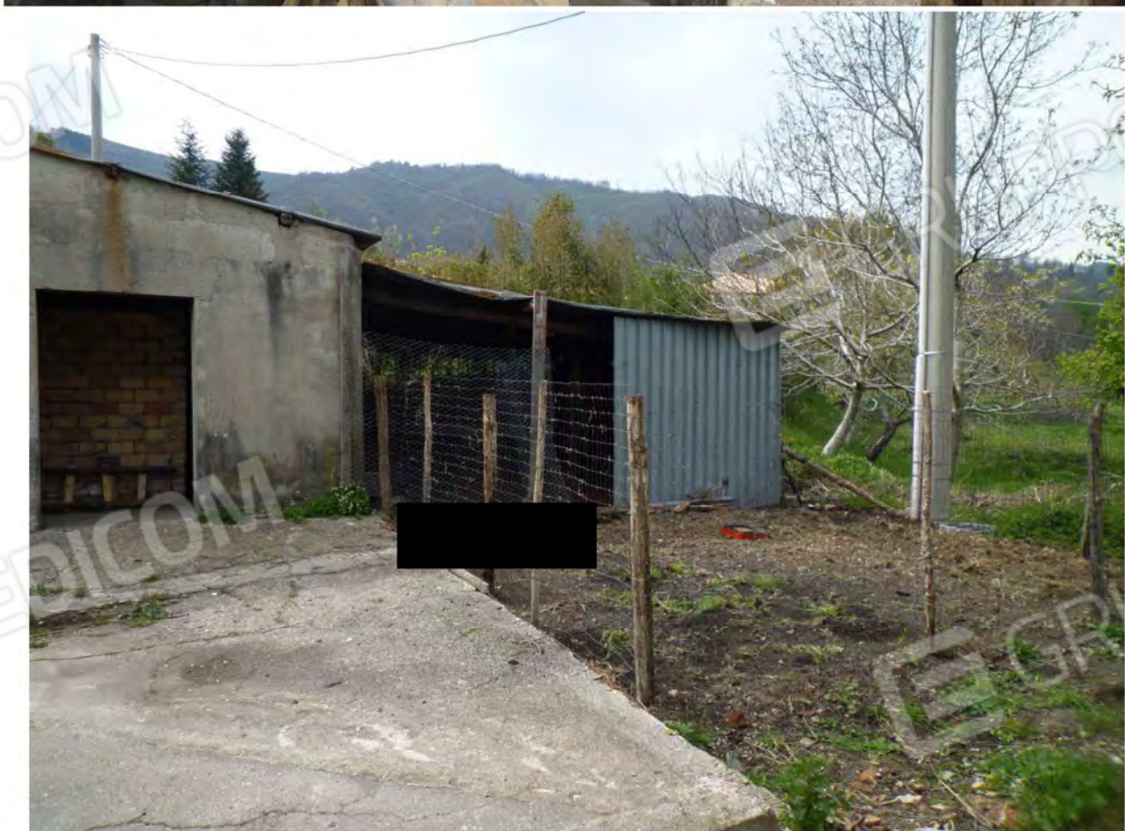
FOTO 46-47-48 retro forni e pollaio
