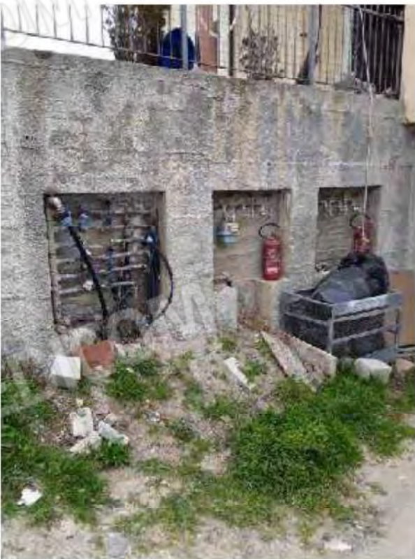
Foto n.3 Contatori acque ed gas all'ingresso dei garages
