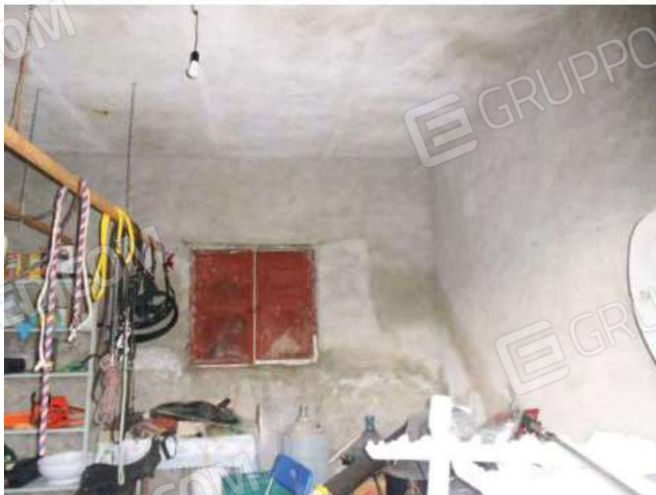
FOTO N. 134: Interni Bene N. 2
