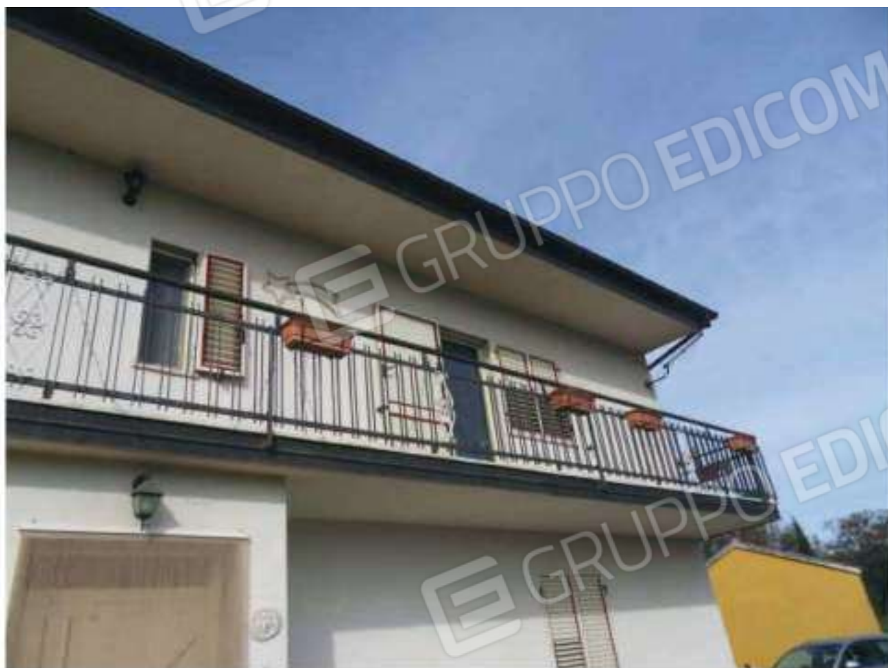
FOTO N. 7: Prospetto SUD - EST Bene N. 1
