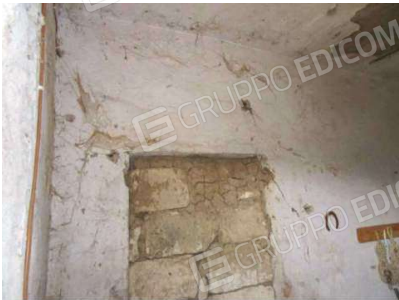
FOTO N. 125: Interni Bene N. 2
