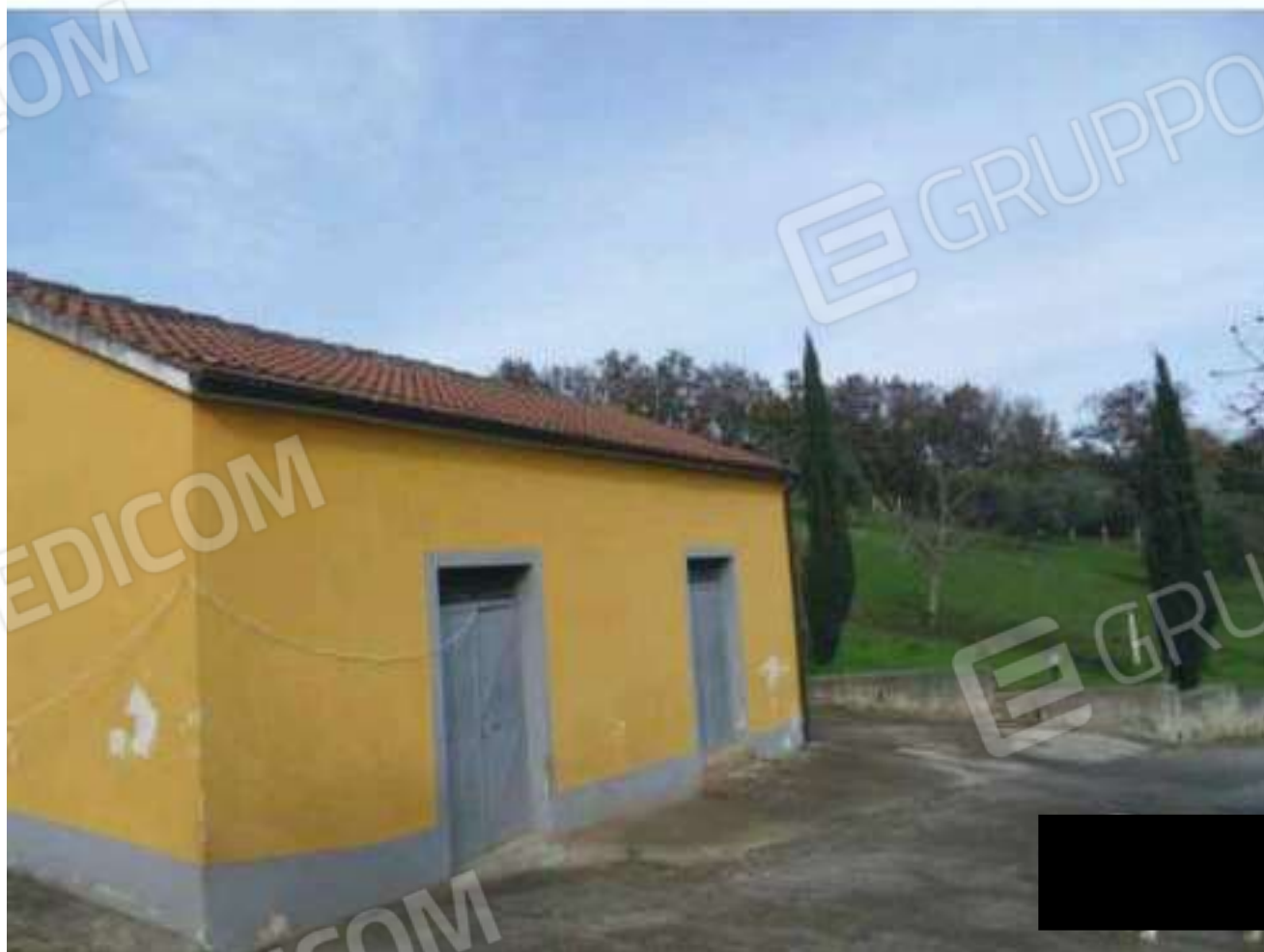
FOTO N. 120: Prospetto EST Bene N. 2
