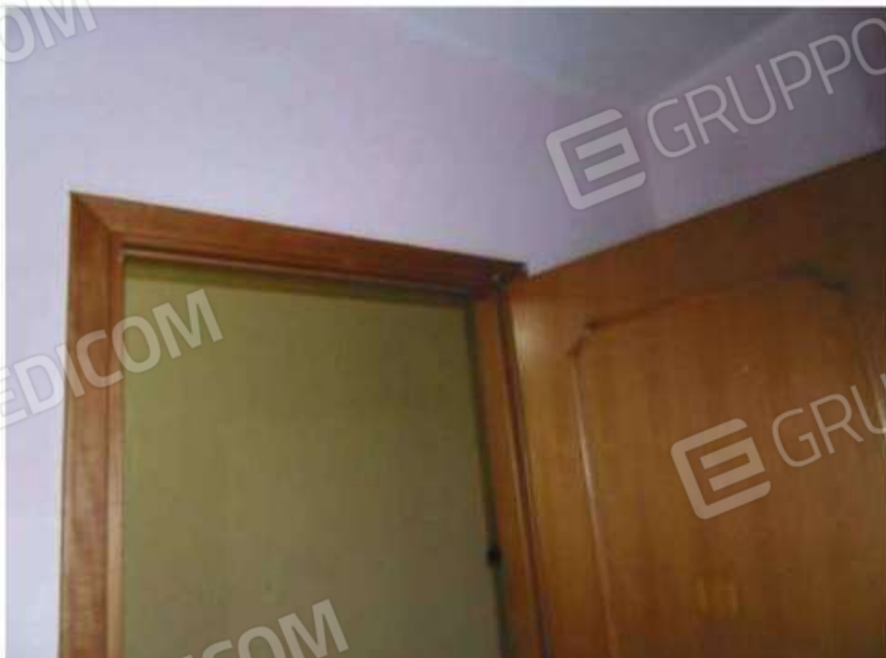
FOTO N. 116: Interni Bene N. 1 (PIANO PRIMO)
