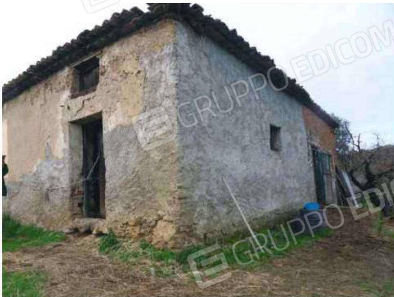
FOTO N. 149: Prospetto SUD – EST Bene N. 3
