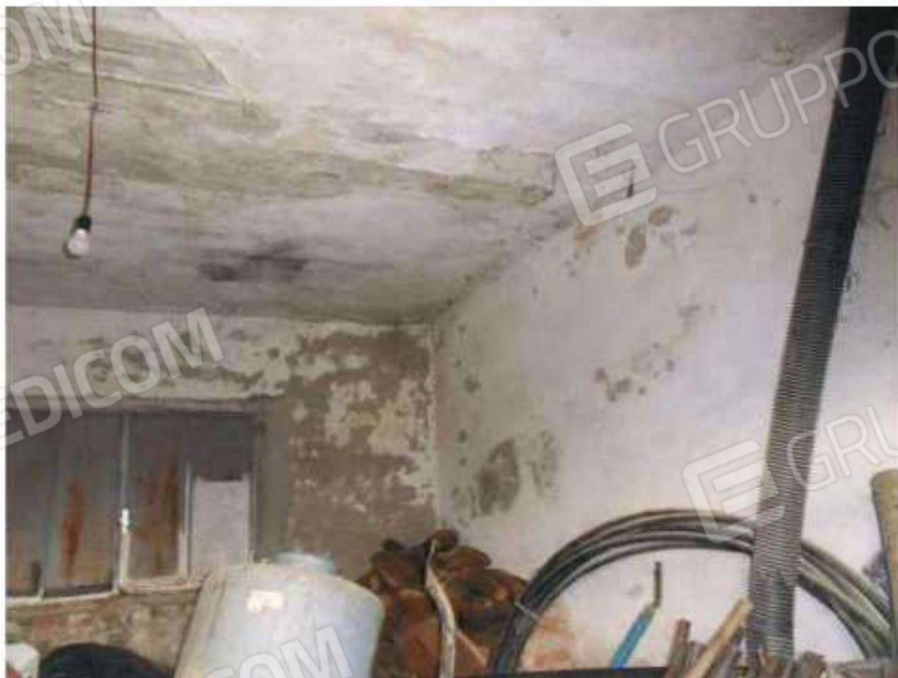
FOTO N. 126: Interni Bene N. 2
