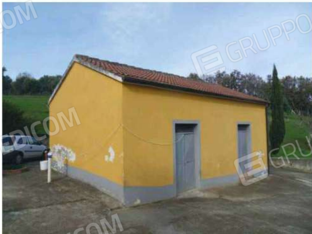
FOTO N. 118: Prospetto SUD - EST Bene N. 2
