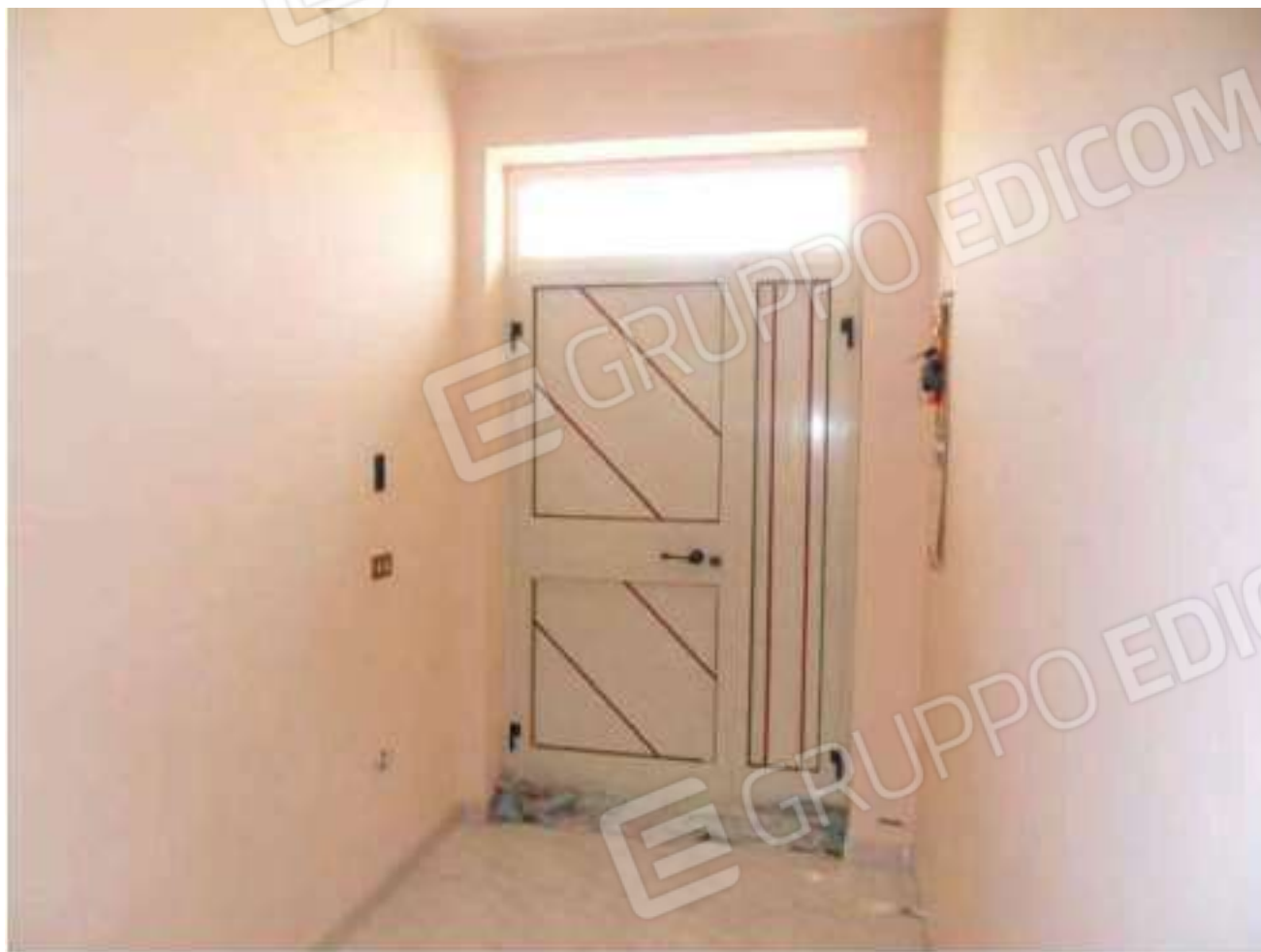
FOTO N. 27: Interni Bene N. 1 (PIANO TERRA)
