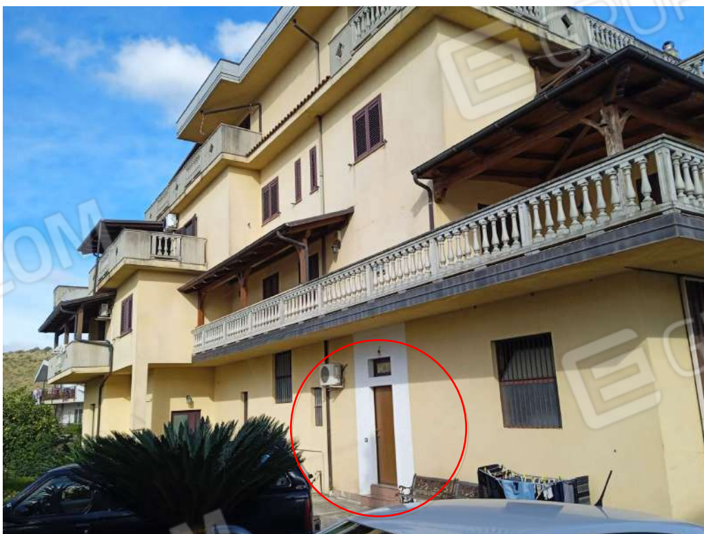
Foto n°2: Altro ingresso esterno al magazzino
