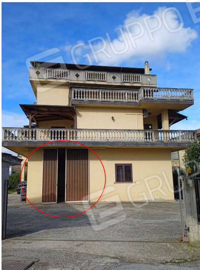
Foto n°1: Particolare evidenziato dell'ingresso esterno al magazzino
