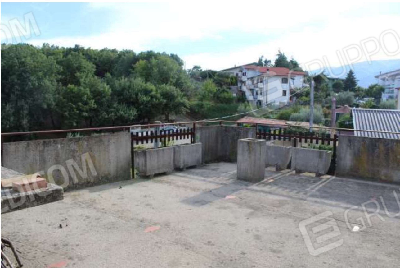
vista terrazzo piano sottotetto
