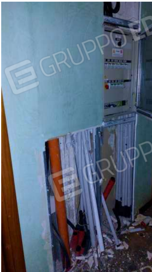
Foto n.39: Piano secondo – Impianti danneggiati e/o divelti
