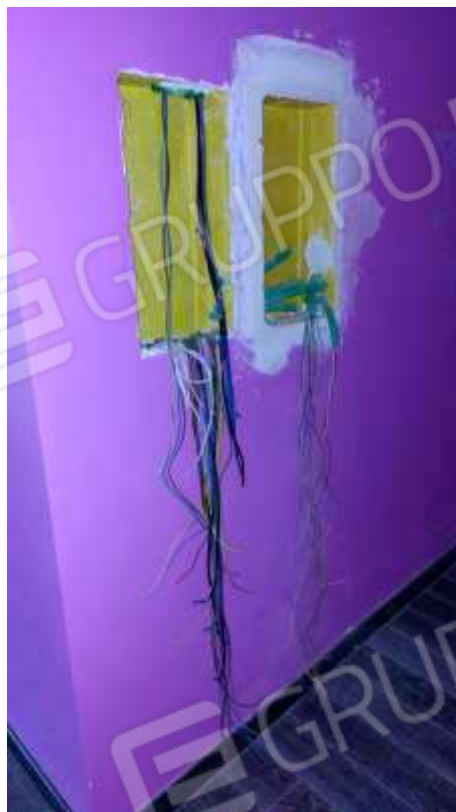
Foto n.43: Piano secondo – Impianti danneggiati e/o divelti
