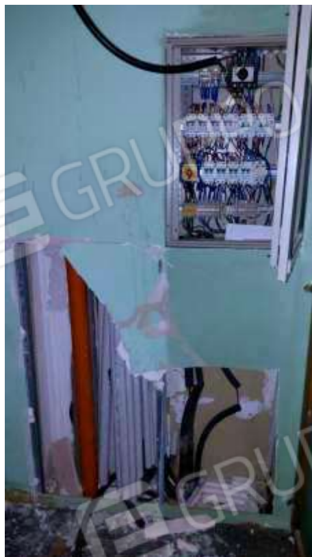
Foto n.29: Piano primo – impianti divelti e/o danneggiati
