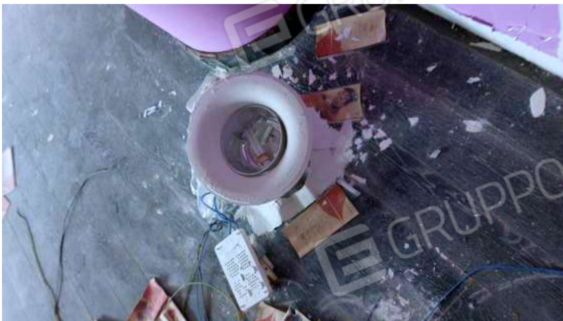
Foto n.42: Piano secondo – Impianti danneggiati e/o divelti
