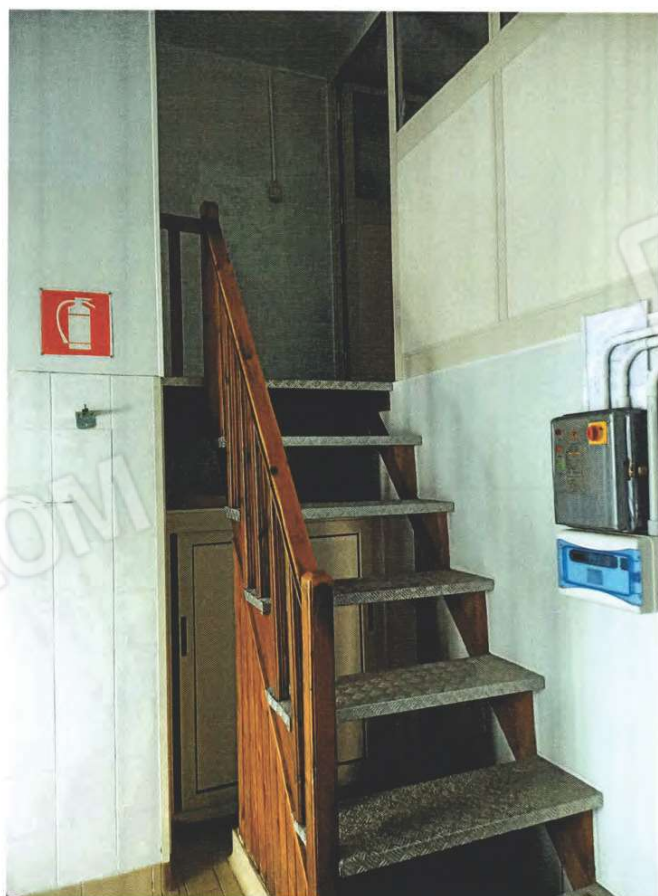
SCALA INGRESSO SOPPALCO NEL SUB. 1
