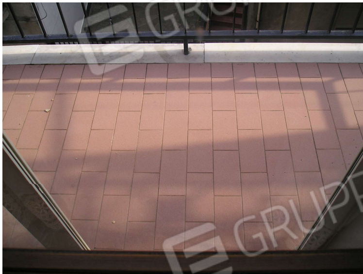
Foto n. 18: particolare balcone - immobile 2
