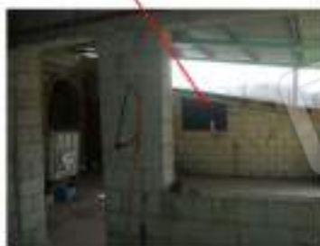
Foto n. 21: vista lato locale adibito ad civile
