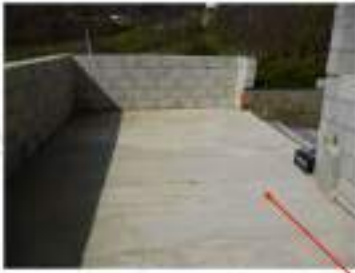
Foto n. 9: terrazzo di copertura per il locale a livello -1 ed il transitto per il deposito del livello 0
