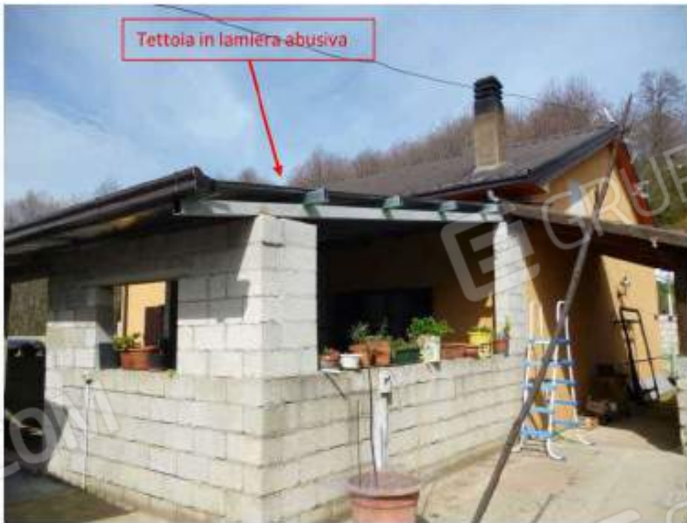
Foto n. 16: fabbricato civile abitazione (foglio 58 p.lla 360) – lato sud/est
