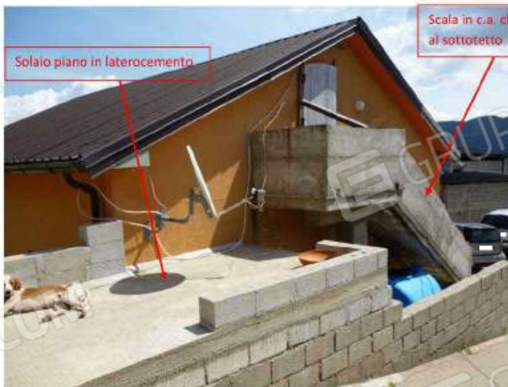
Foto n. 18: fabbricato civile abitazione (foglio 58 p.lla 360) – lato nord
