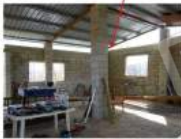
Foto n. 13: interno locale deposito
