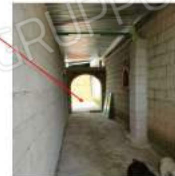
Foto n. 31: corridoio d'ingresso locale
