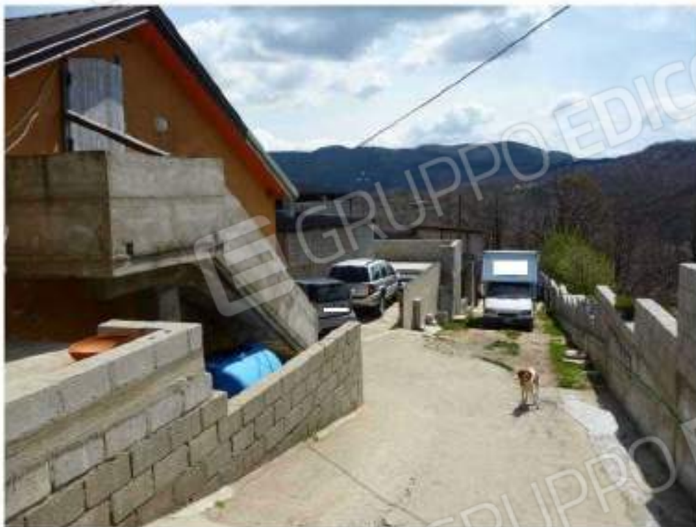
Foto n. 3: ingresso vista sud
