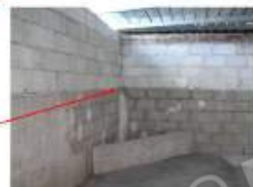
Foto n. 30: interno locale deposito
