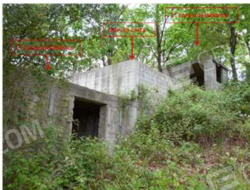
Foto n. 20: corpi di fabbrica – lato est
