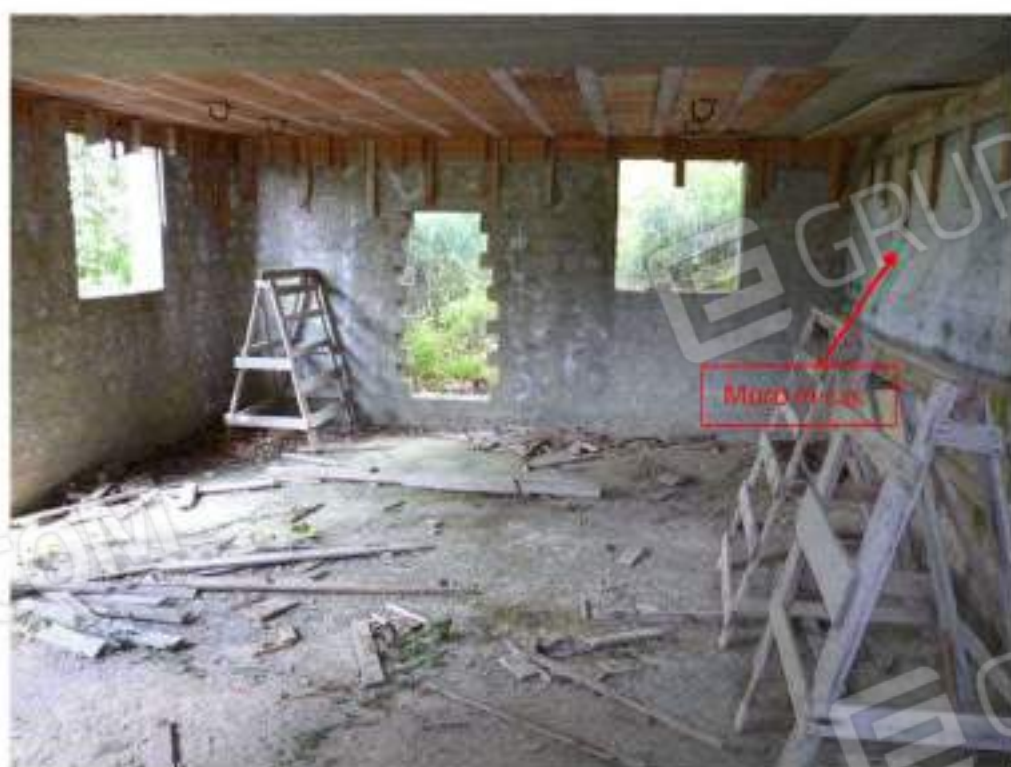
Foto n. 18: 2° corpo di fabbrica - vista interna
