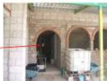
Foto n. 23: ingresso locale deposito
