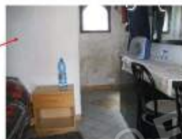
Foto n. 7: interno locale deposito
