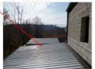
Foto n. 16: coperture locali livello -1
