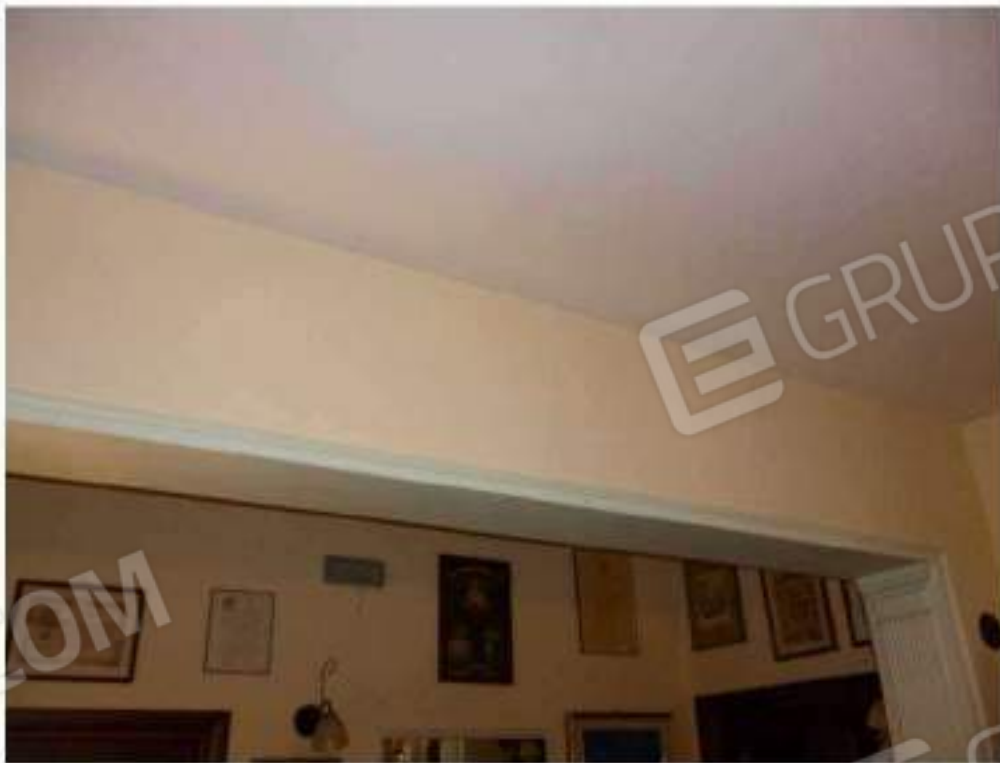
Foto n. 20: fabbricato civile abitazione (foglio 58 p.lla 360) - vista interna
