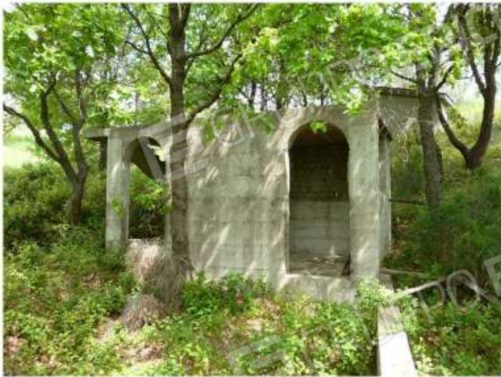
Foto n. 11: 1° corpo di fabbrica – lato sud
