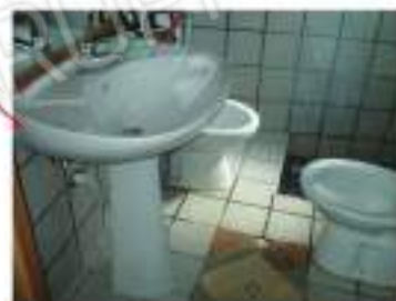
Foto n. 8: bagno annesso al locale deposito
