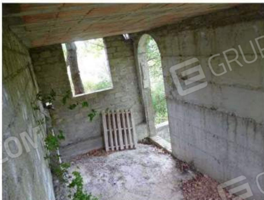
Foto n. 14: 1° corpo di fabbrica - vista interna
