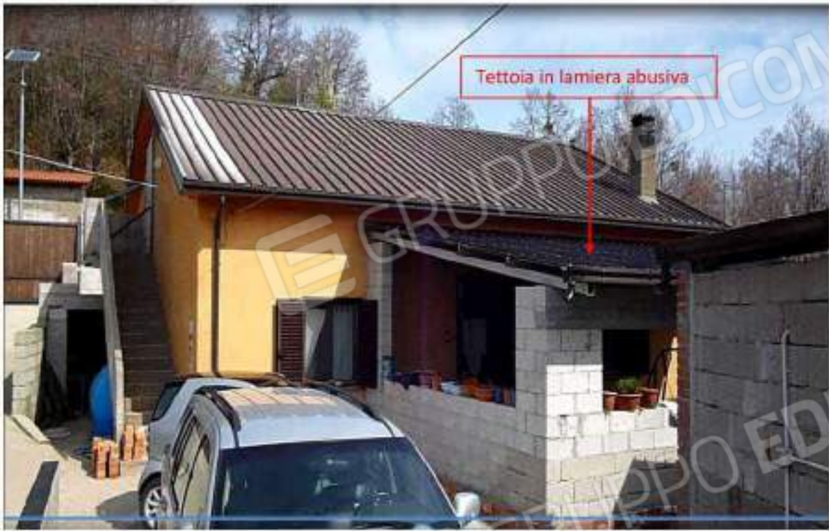
Foto n. 15: fabbricato civile abitazione (foglio 58 p.lla 360) – lato sud/ovest
