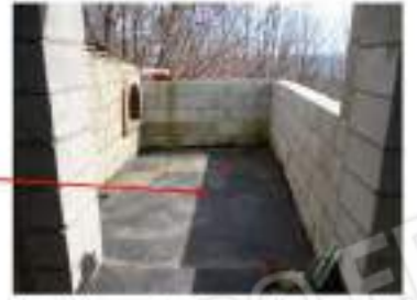
Foto n. 15: terrazzo di copertura per il locale a livello -1
