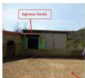
Foto n. 32: corteo cavalli - vista locale adibito a fienile
