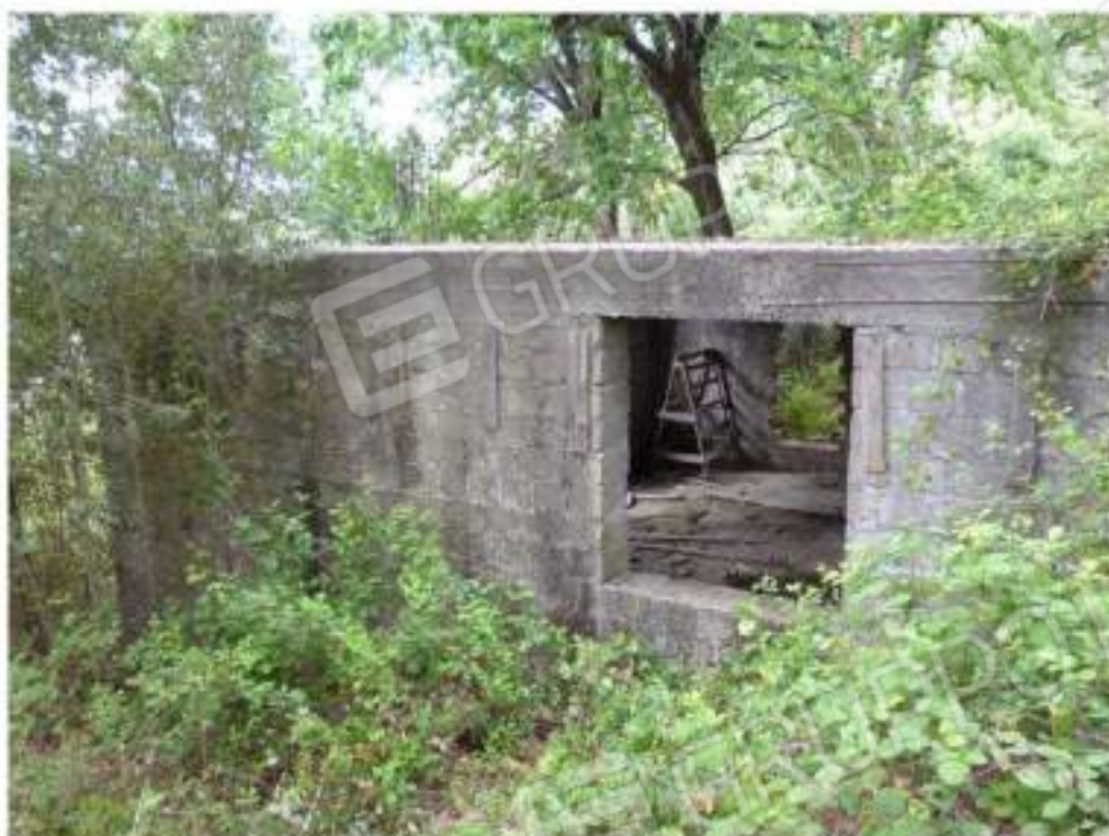
Foto n. 17: 2° corpo di fabbrica – lato est
