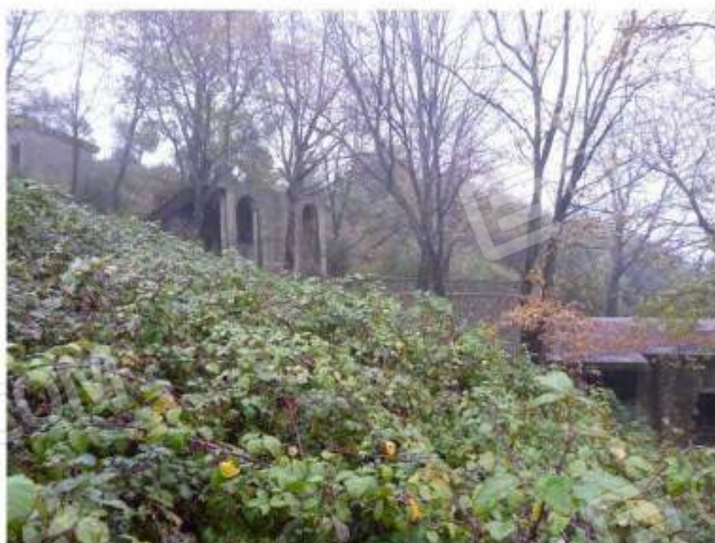
Foto n. 8: costruzioni abusive lato ovest
