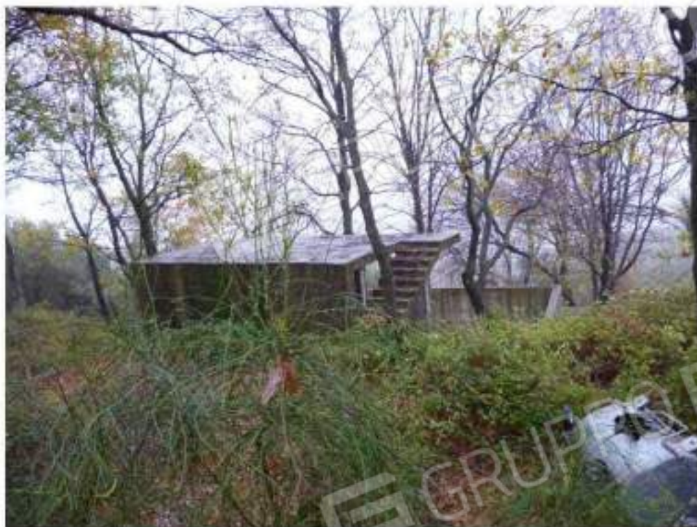
Foto n. 7: costruzioni abusive lato nord
