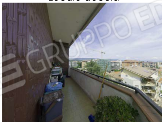
Balcone lato nord
