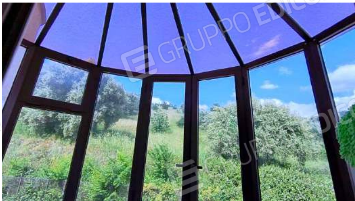
Foto 25 - Appartamento al piano primo, balcone cucina chiuso a veranda.
