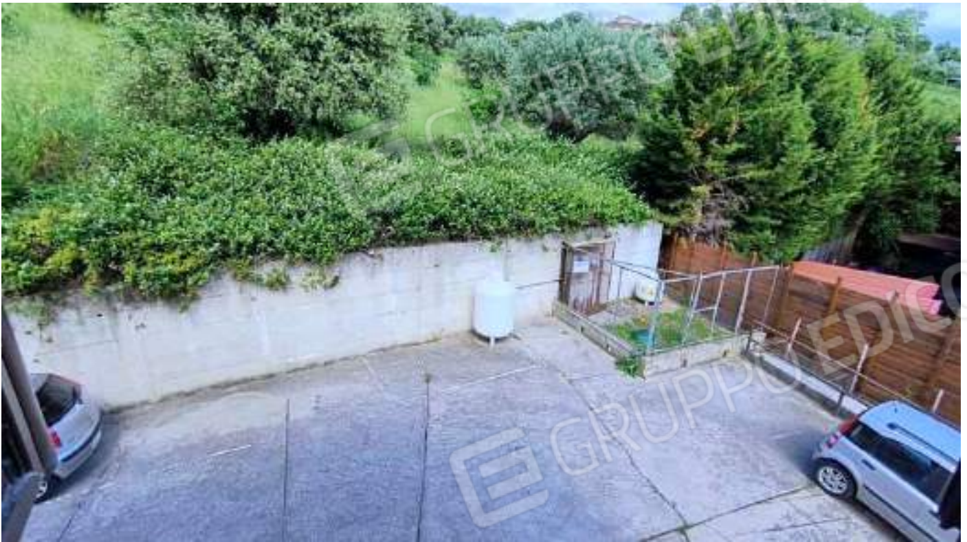
Foto 31 - Serbatoio GPL nella corte comune.
