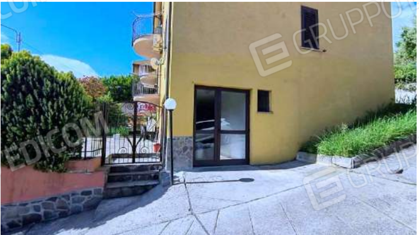
Foto 32 - Ingresso esterno al laboratorio al piano seminterrato e alla corte esclusiva dalla corte comune.
