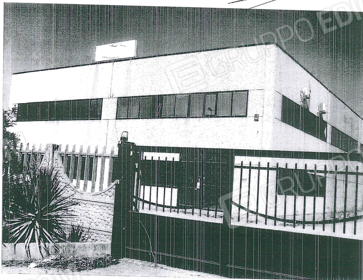
Foglio 28 Part.lla 105 San Marco Argentano (CS) - FOTO 4 -
