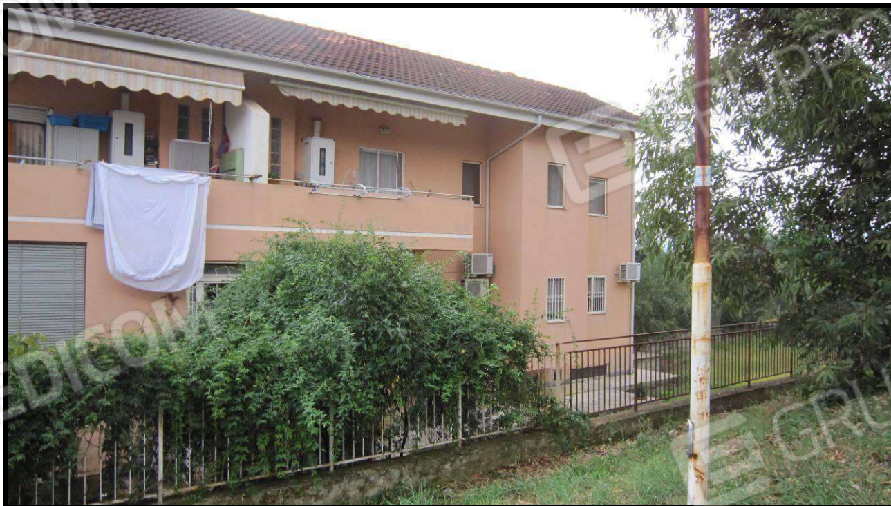
Foto 2 Fabbricato part. 755 in vista da Nord-Ovest
