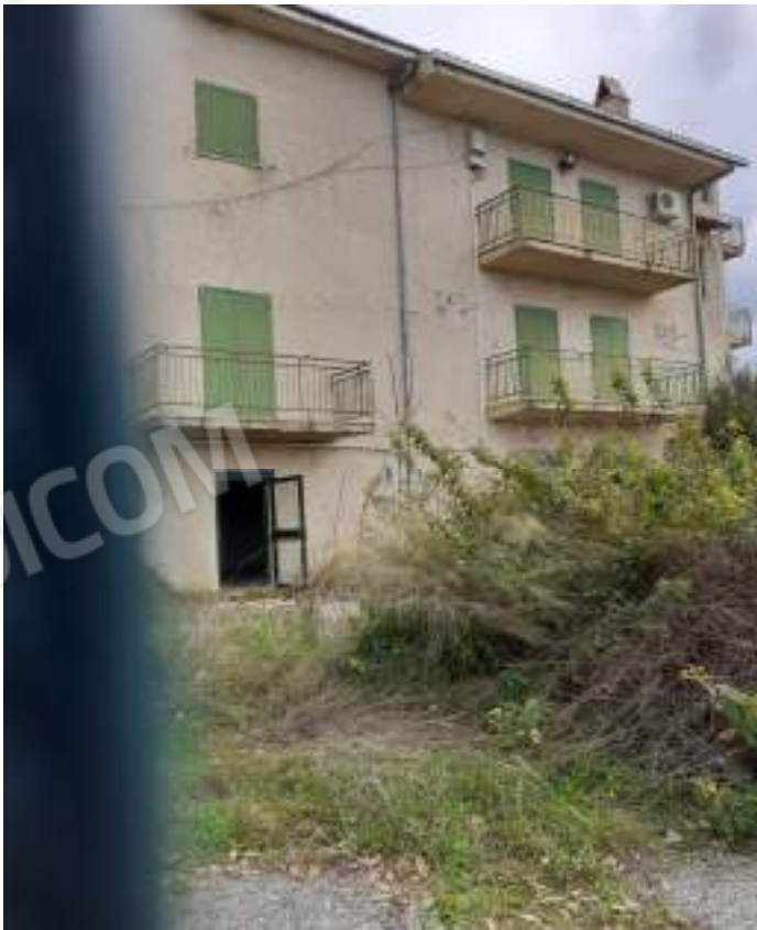
PART 458 VISTA LATO OVEST
