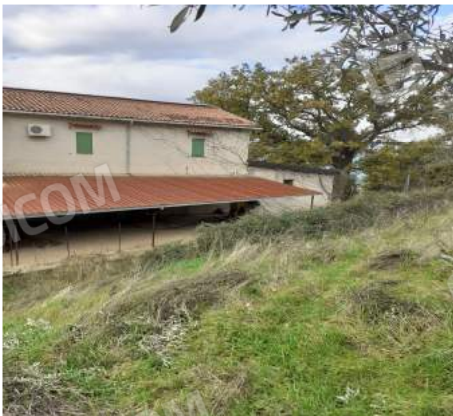
PART 458 VISTA LATO EST TETTOIA
