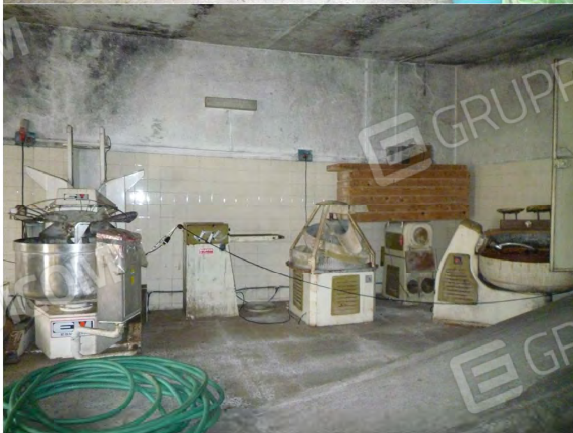
FOTO 42-43 macchinari sala lavorazione 4 traccia filo elettrico aereo
