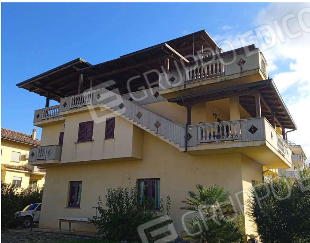
Foto n°17: Vista esterna dell'unità immobiliare
