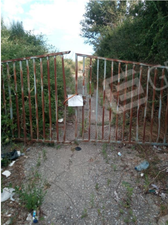
Foto n. 3 – Il cancello all'ingresso
