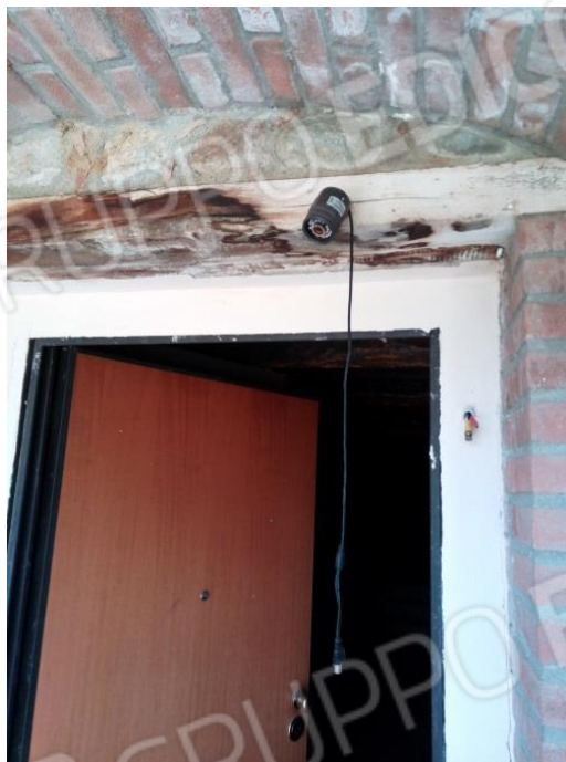
Foto n. 20 – Ingresso al p. terra
