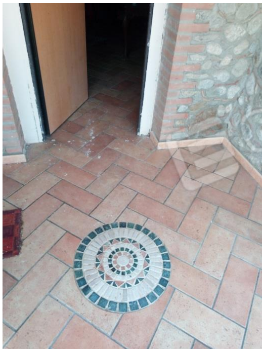
Foto n. 19 – Ingresso al p. terra
