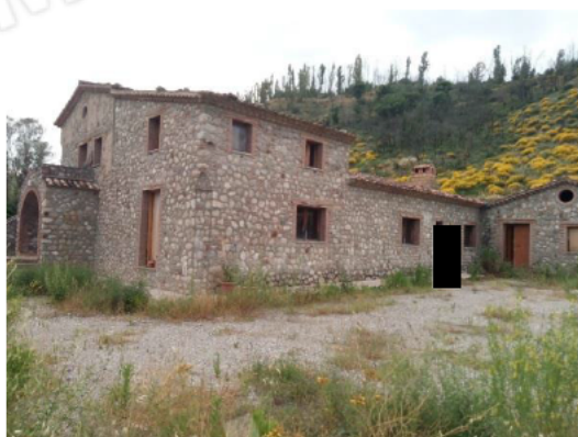
Foto n. 5 – Fabbricato, lato est
