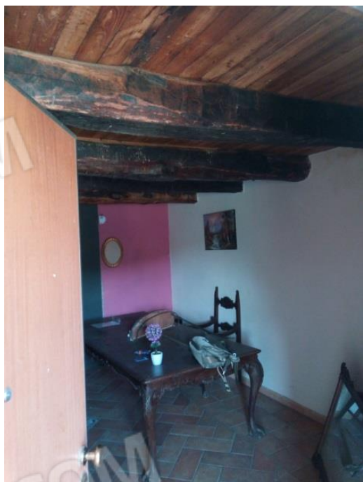
Foto n. 21 – Vano d'ingresso al p. terra
