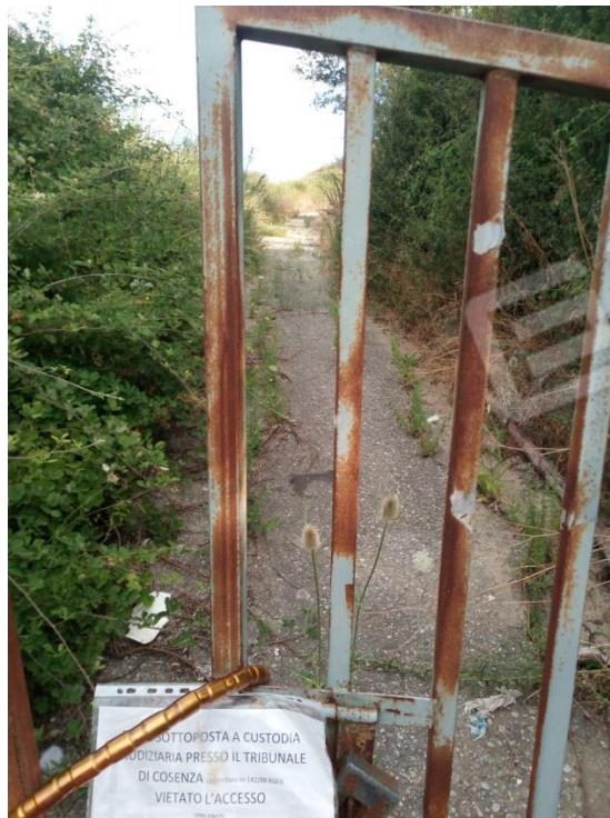
Foto n. 5 – Il cancello all'ingresso
