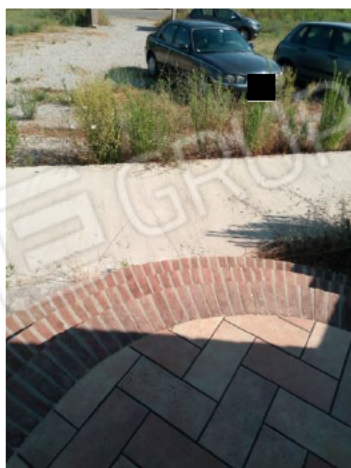
Foto n. 16 – Gradini d'accesso al p. terra
