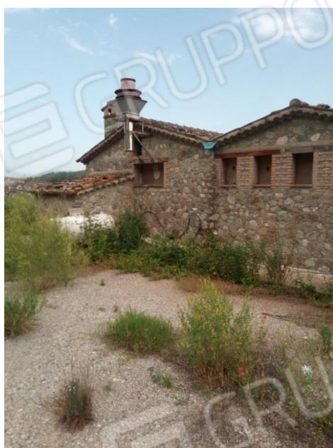
Foto n. 9 – Fabbricato, lato nord
