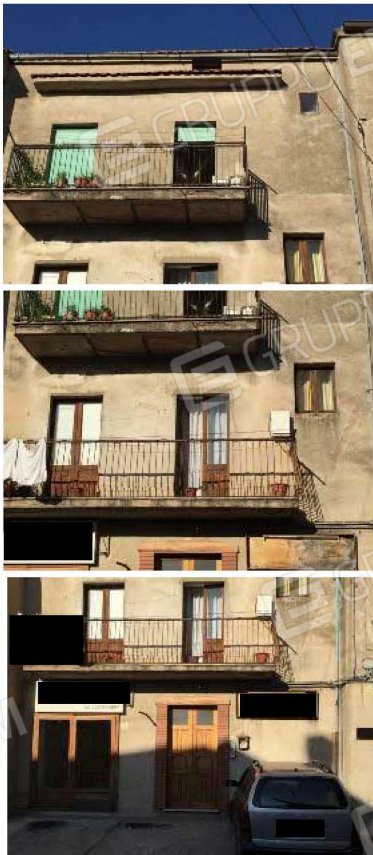
Prospetto su via Principe di Piemonte
