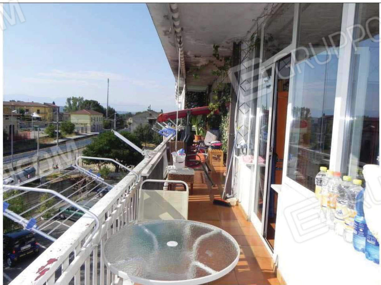
Foto n.30: particolare terrazzo lato OVEST
