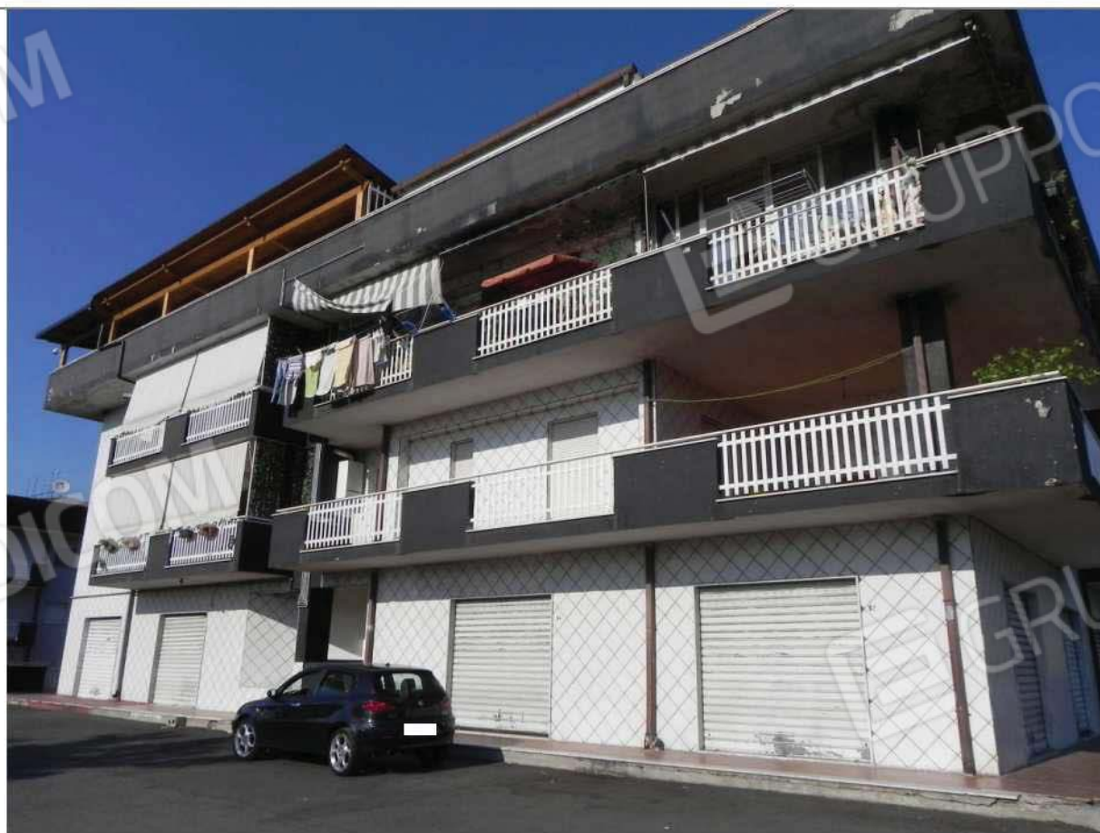
Foto n.2: prospetto lato OVEST
