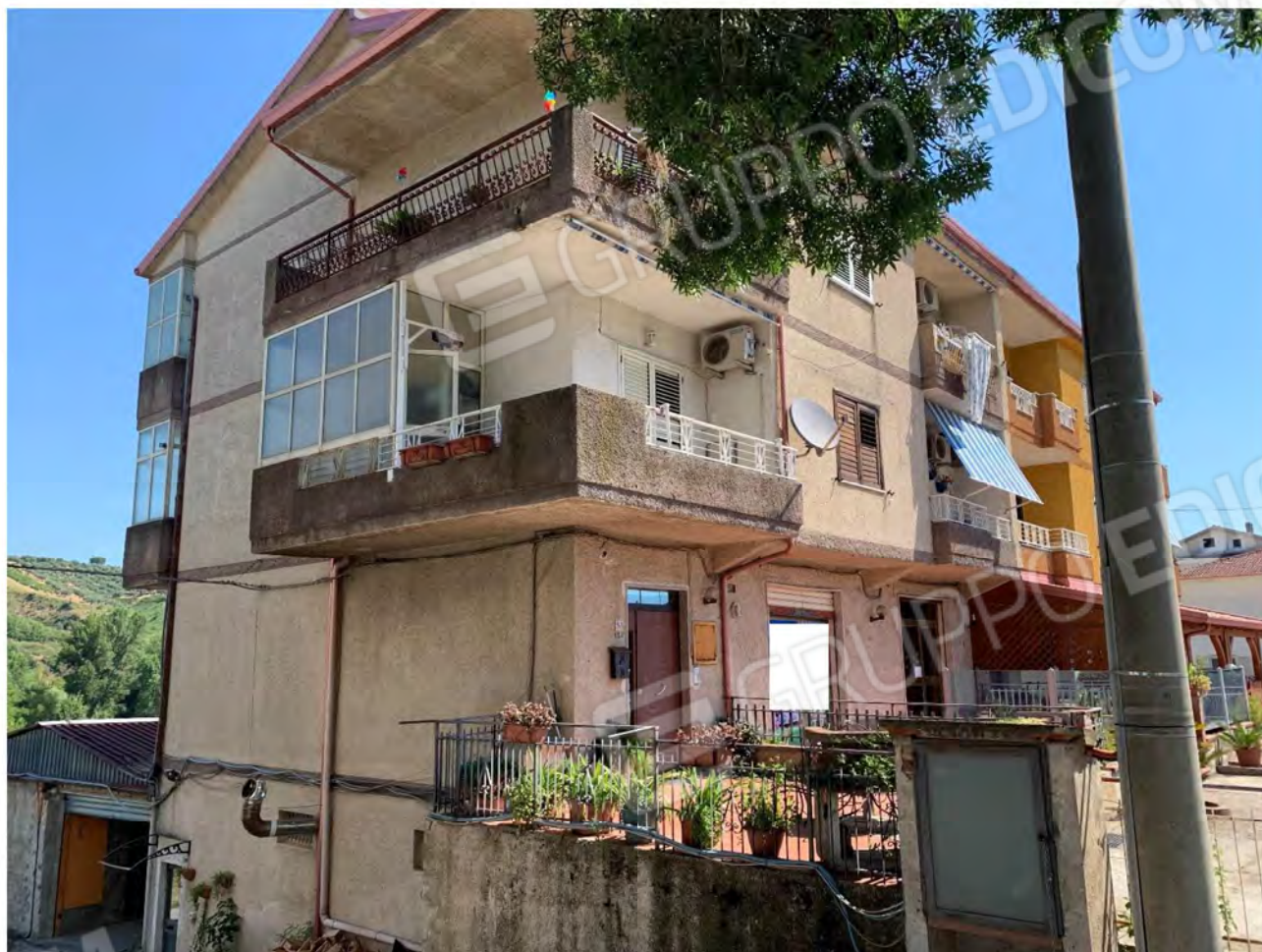
All. 4a2 - Facciata principale
