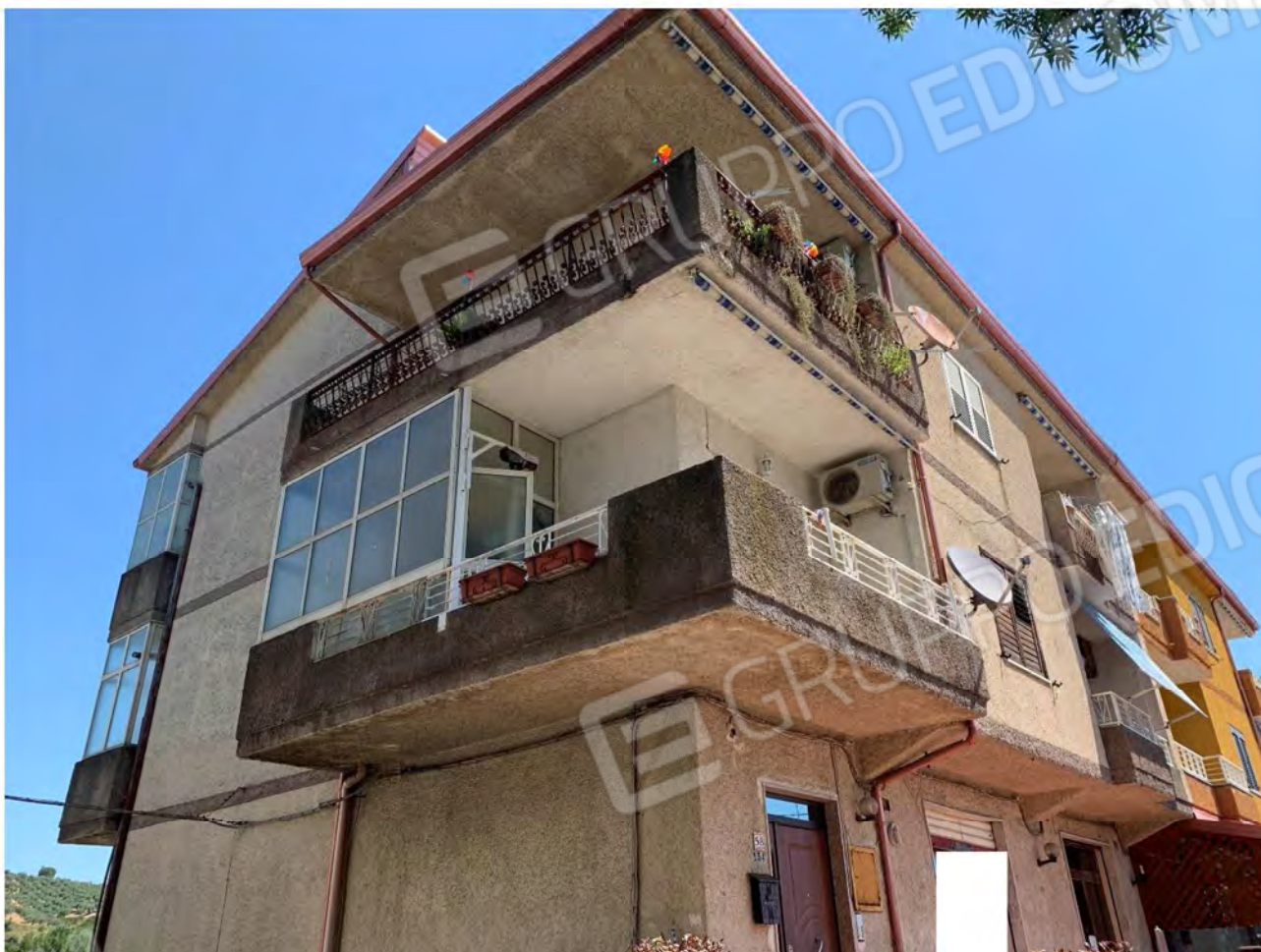
All. 4b2 - Secondo piano vista sud-est
