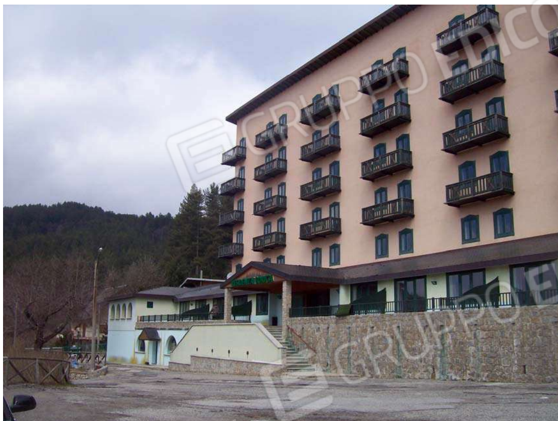
Foto 1 – Ingresso alla struttura
