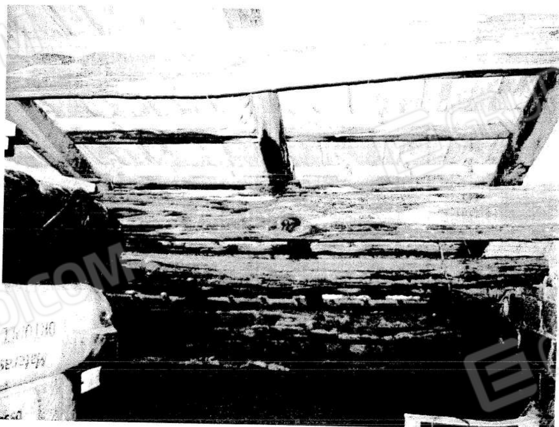
Foto n°. 10 – Copertura
