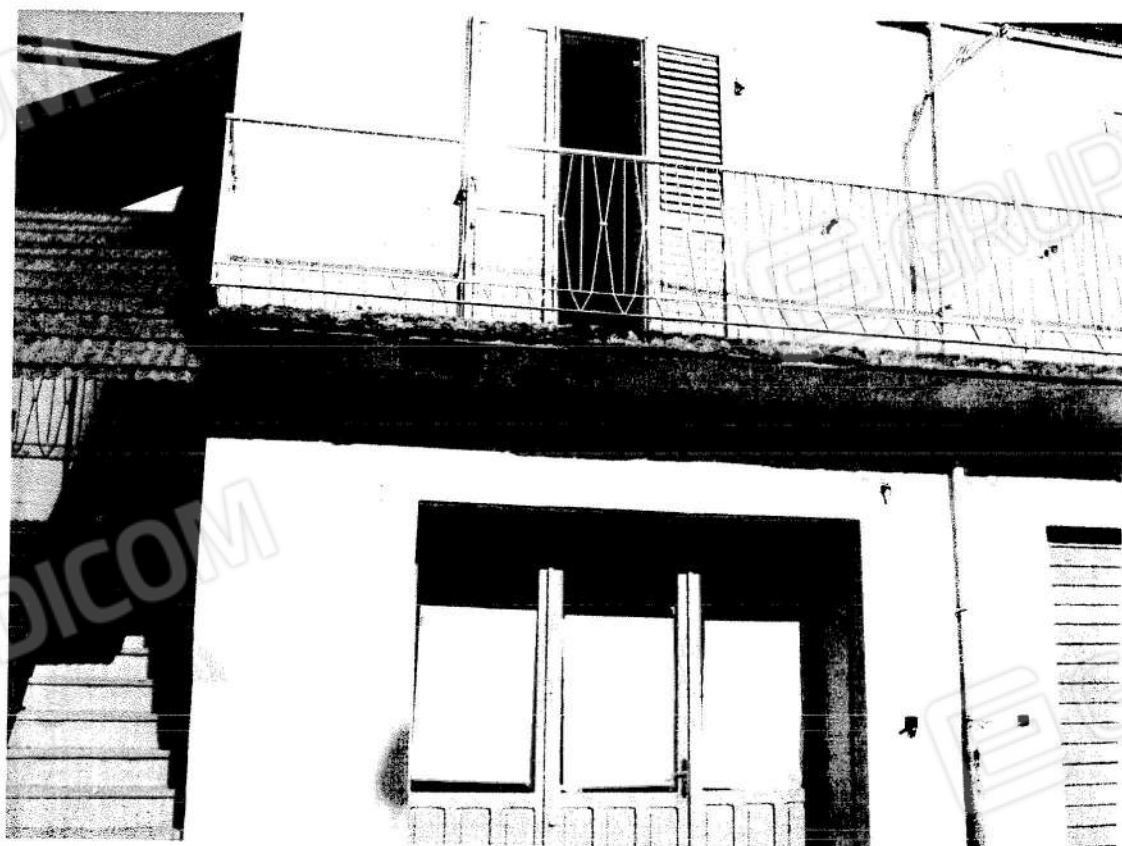
Foto n°. 15 - Balcone
