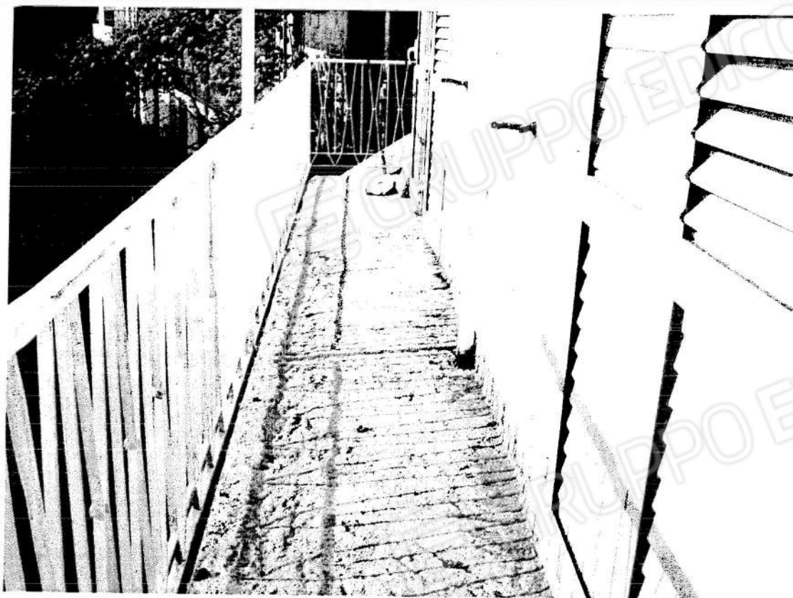
Foto n°. 14 – Balcone
