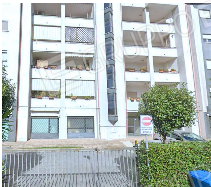
Foto 1 Immobile foglio 6 part. 845 sub. 52
