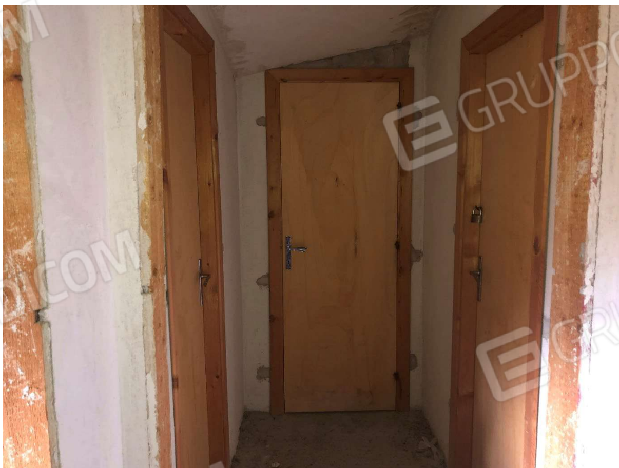
Foto 30 - Porta di ingresso soffitta piano terzo/sottotetto.
