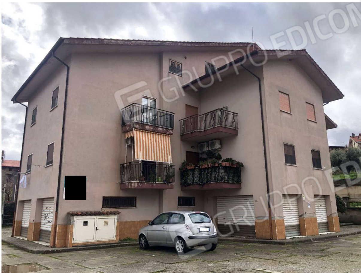
Foto 1 - Fabbricato in Marano Marchesato, Via Morroni n.33.
