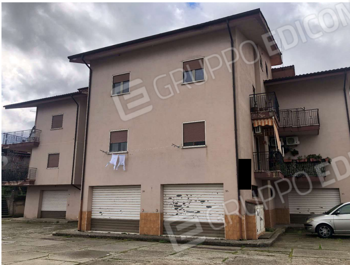
Foto 3 - Fabbricato in Marano Marchesato, Via Morroni n.33.
