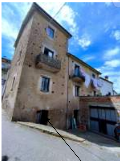
Prospetto Nord — ingresso magazzino
