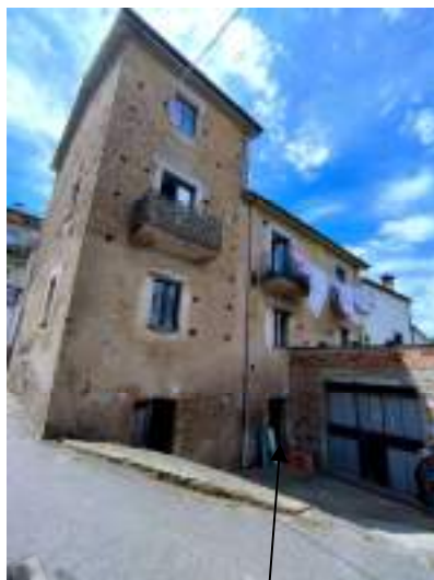
Prospetto Nord – Ingresso magazzino
