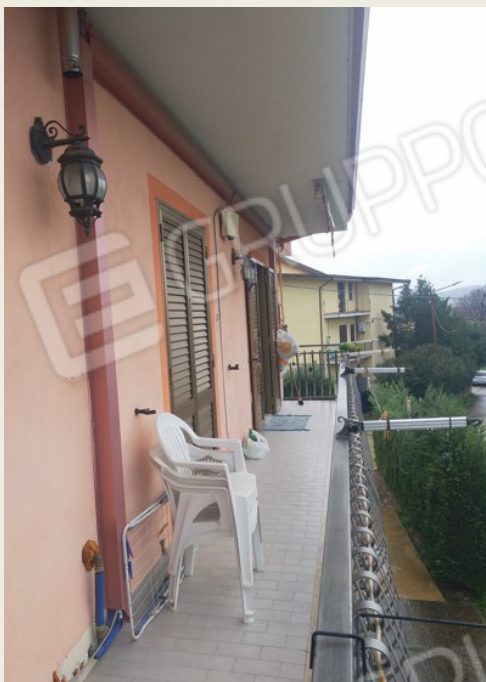
FOTO N° 12 – BALCONE - PIANO PRIMO - FOGLIO 41 - PARTICELLA 315 – SUB 6
