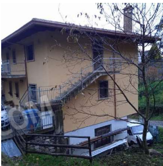
PIANO TERRA E PIANO PRIMO LATO OVEST
