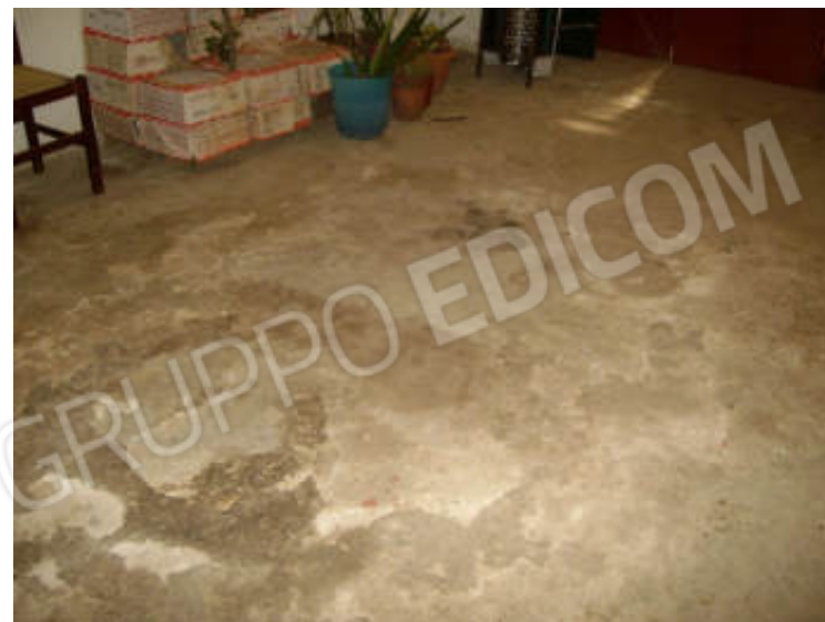
Foto n°18: sub n°3, Magazzino deposito (1); Pavimentazione
