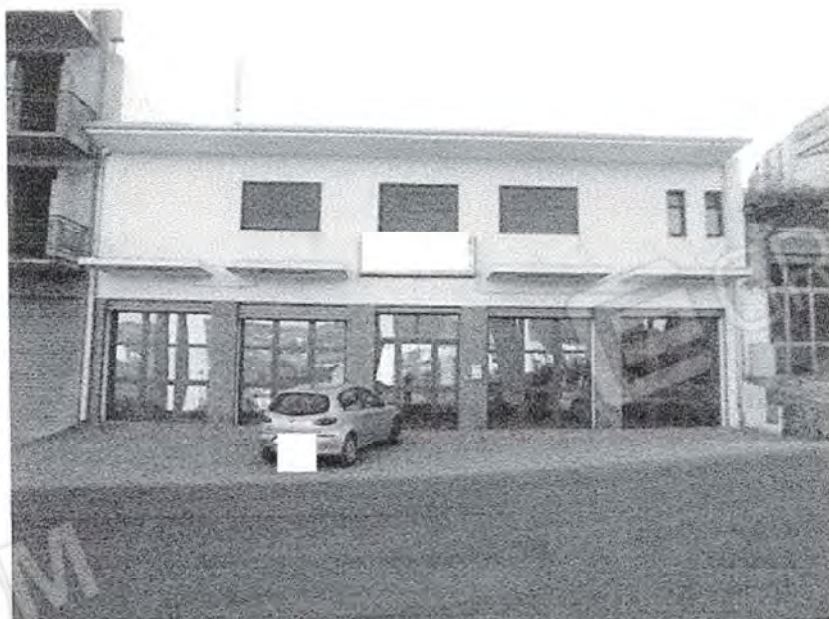
Vista esterna Lotti N. 6-7
