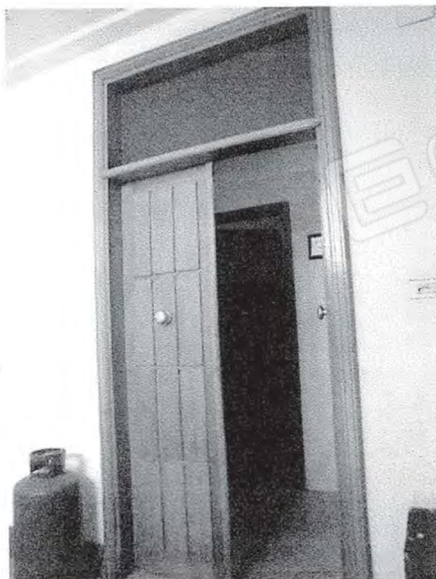
Vista interna Lotto N. 5
