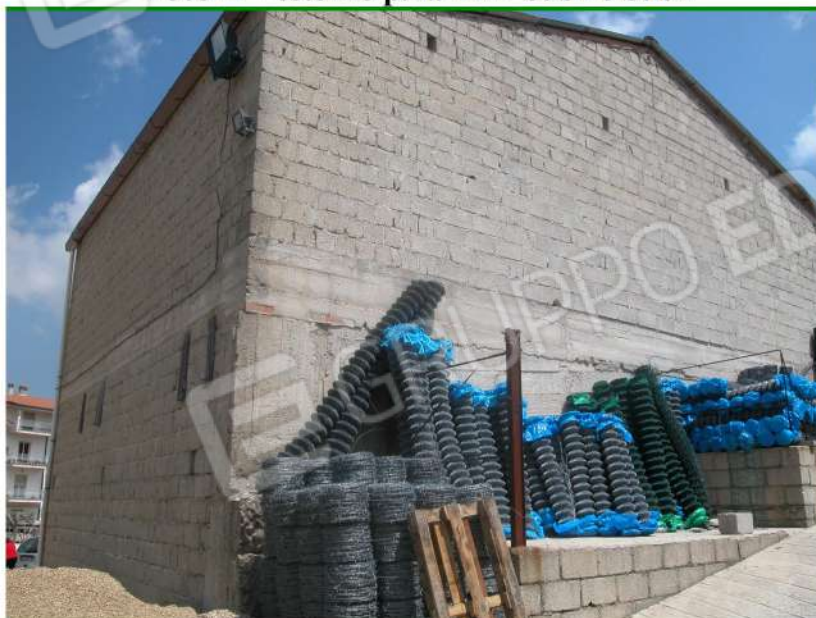
Foto 4 - esterno p.lla 1569 Sub1 e Sub2
