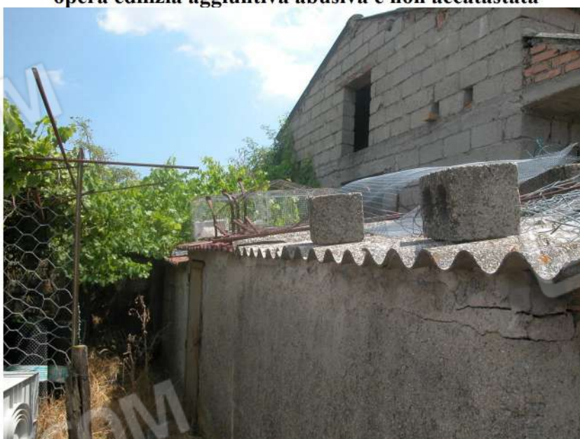
Foto 33 - esterno p.lla 1568 e sullo sfondo a sinistra p.lle 2217 e 2218
