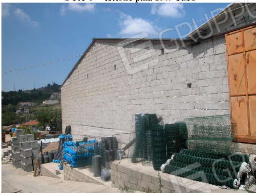
Foto 5 - esterno p.lla 1569 Sub1
