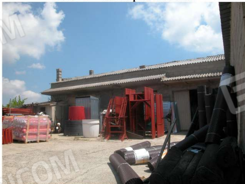
Foto 30 - esterno p.lla 1570 Sub1
