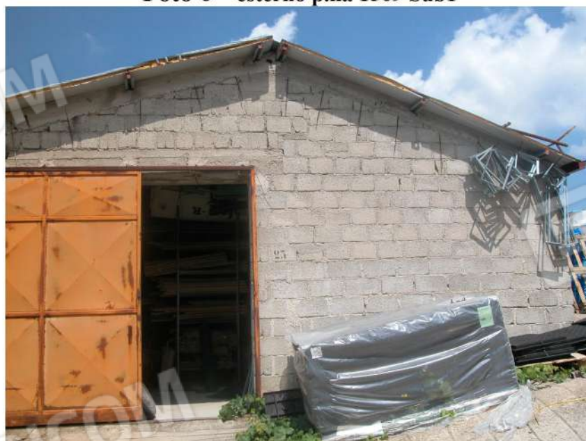
Foto 6 - esterno p.lla 1569 Sub1
