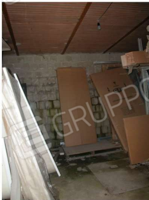
Foto 22 - interno p.lla 1569 Sub2
