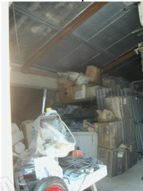
Foto 20 - interno p.lla 1569 Sub1
