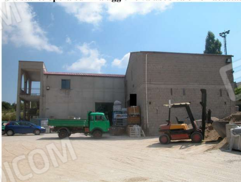
Foto 3 - esterno p.lla 1569 Sub1 e Sub2 con antistante opera edilizia aggiuntiva abusiva e non accatastata
