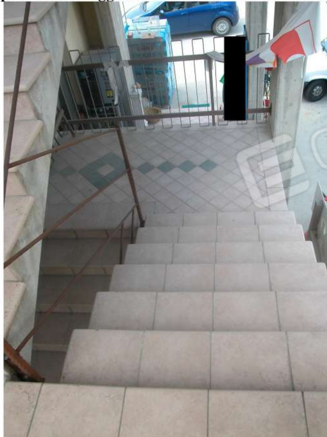
Foto 11 - esterno p.la 1568 e p.la 1569 Sub1 e Sub2 opera edilizia aggiuntiva abusiva e non accatastata
