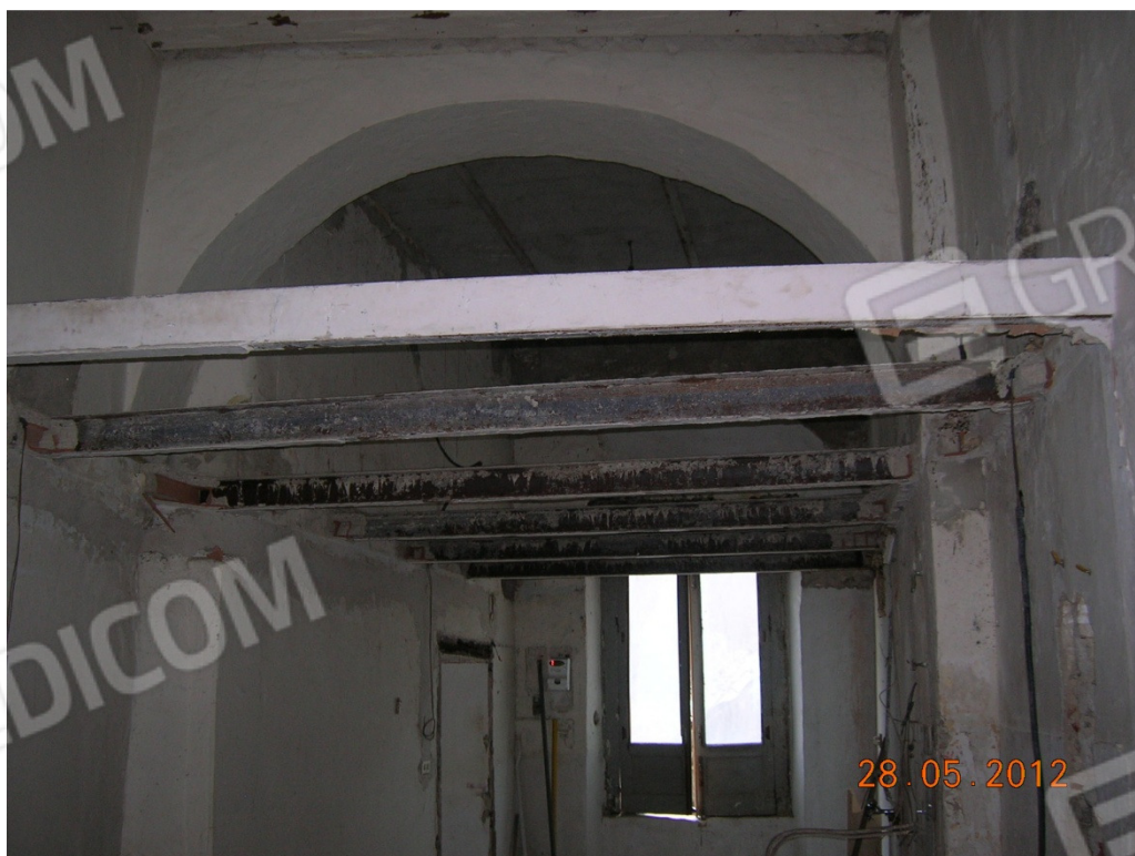
FOTO N. 08 STRUTTURA DEL SOLAIO
