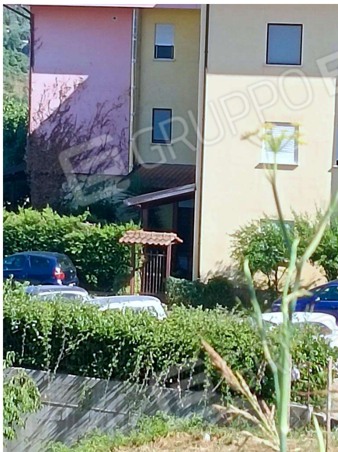
Figura 3 – Ingresso esclusivo corte appartamento pignorato
