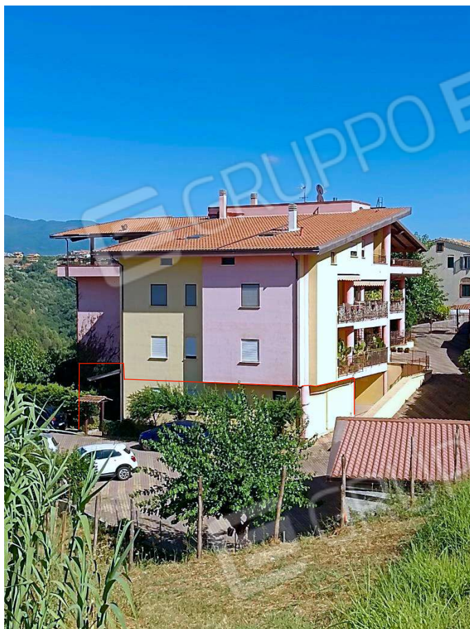
Figura 1 – Vista lato Sud-Ovest e Sud-Ovest
