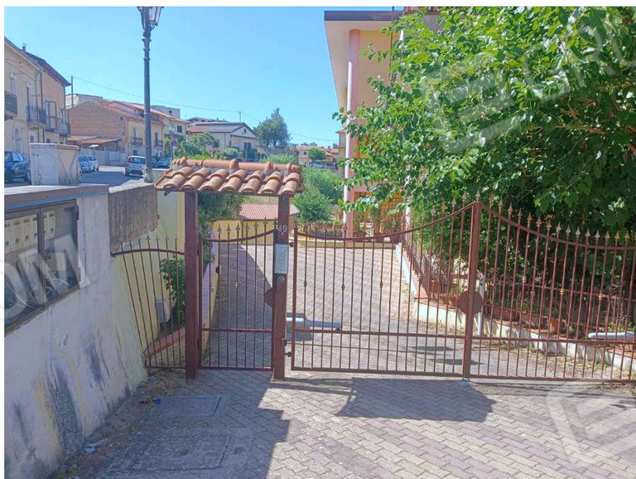
Figura 2 – Ingresso pedonale e carrabile condominiale
