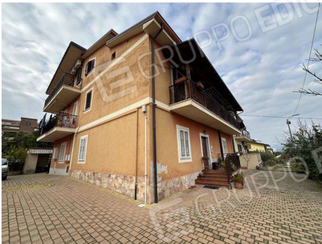
Foto 1: Vista esterna immobile.
