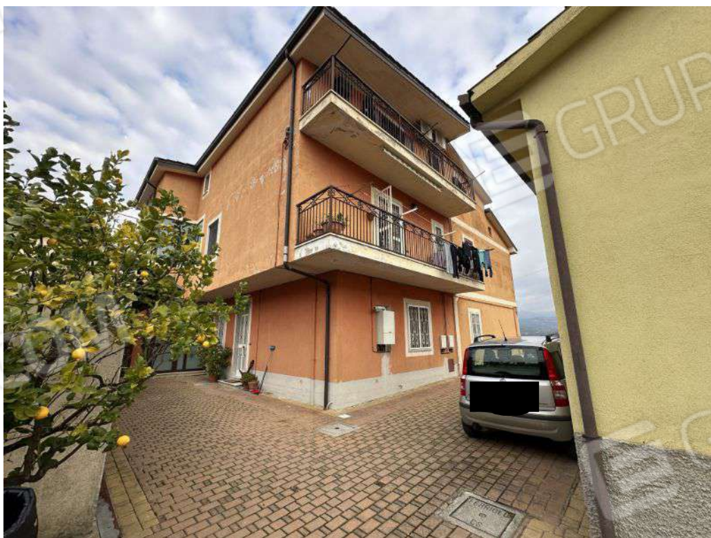
Foto 2: Vista esterna immobile.
