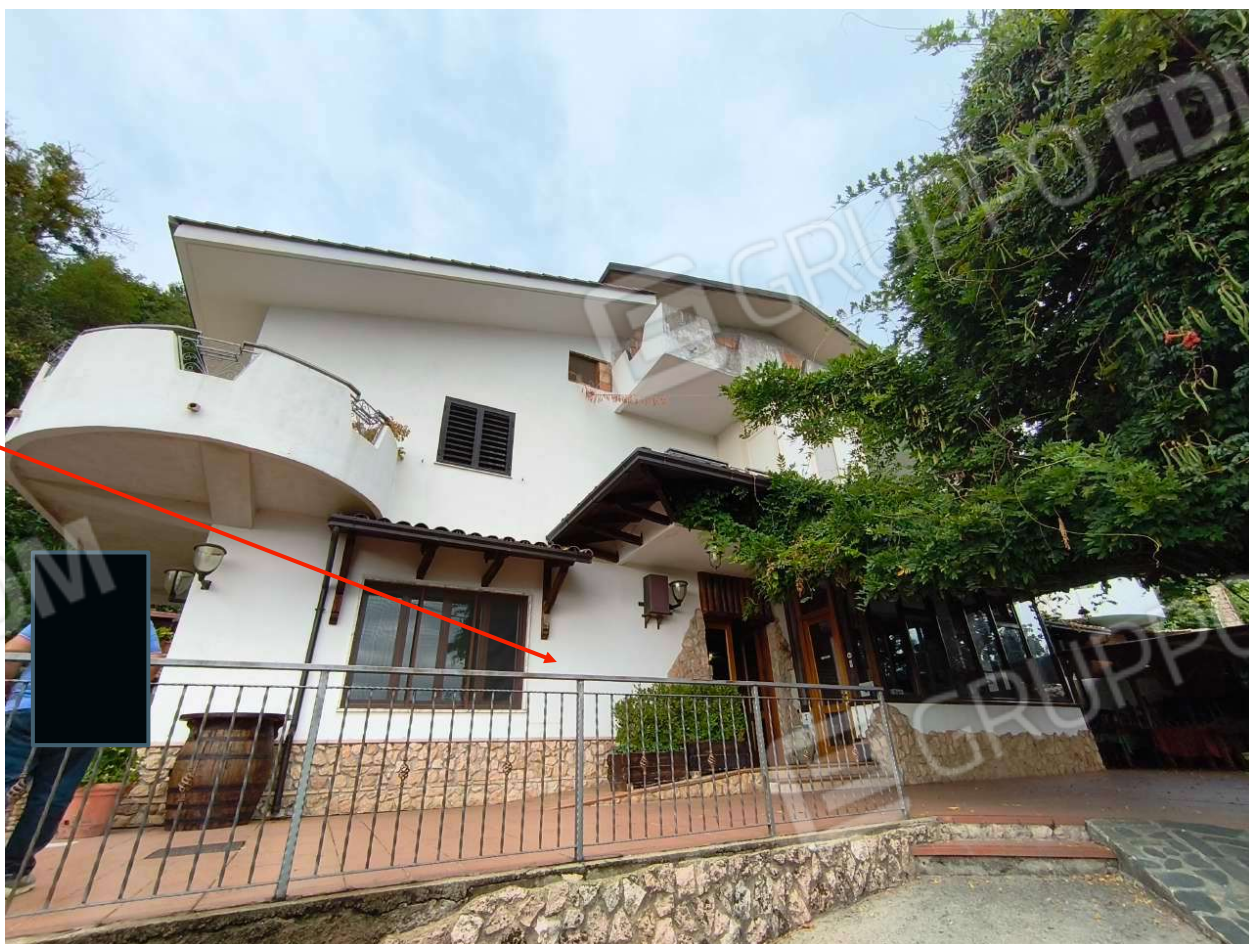
Foto n. 5: Fabbricato di cui fa parte l'immobile pignorato
