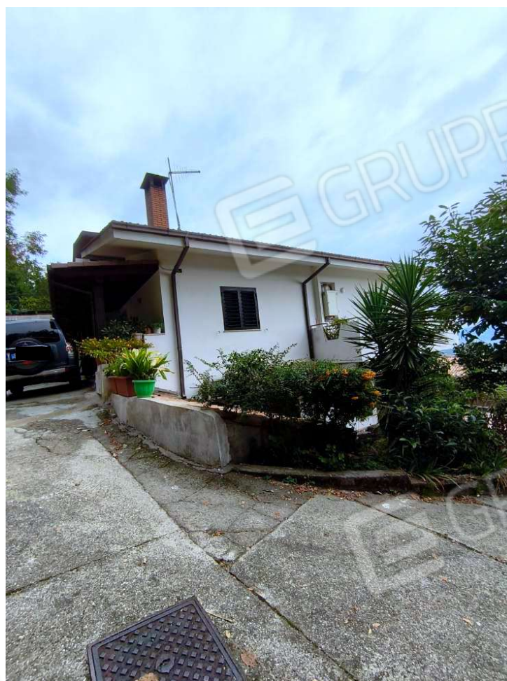
Foto n. 7: Fabbricato di cui fa parte l'immobile pignorato
