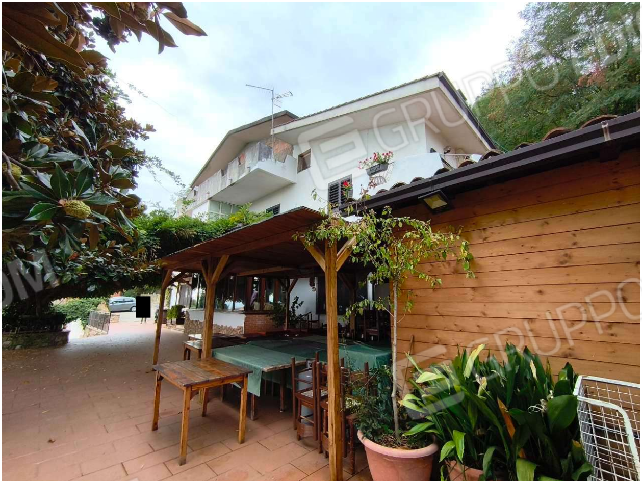
Foto n. 6: Fabbricato di cui fa parte l'immobile pignorato
