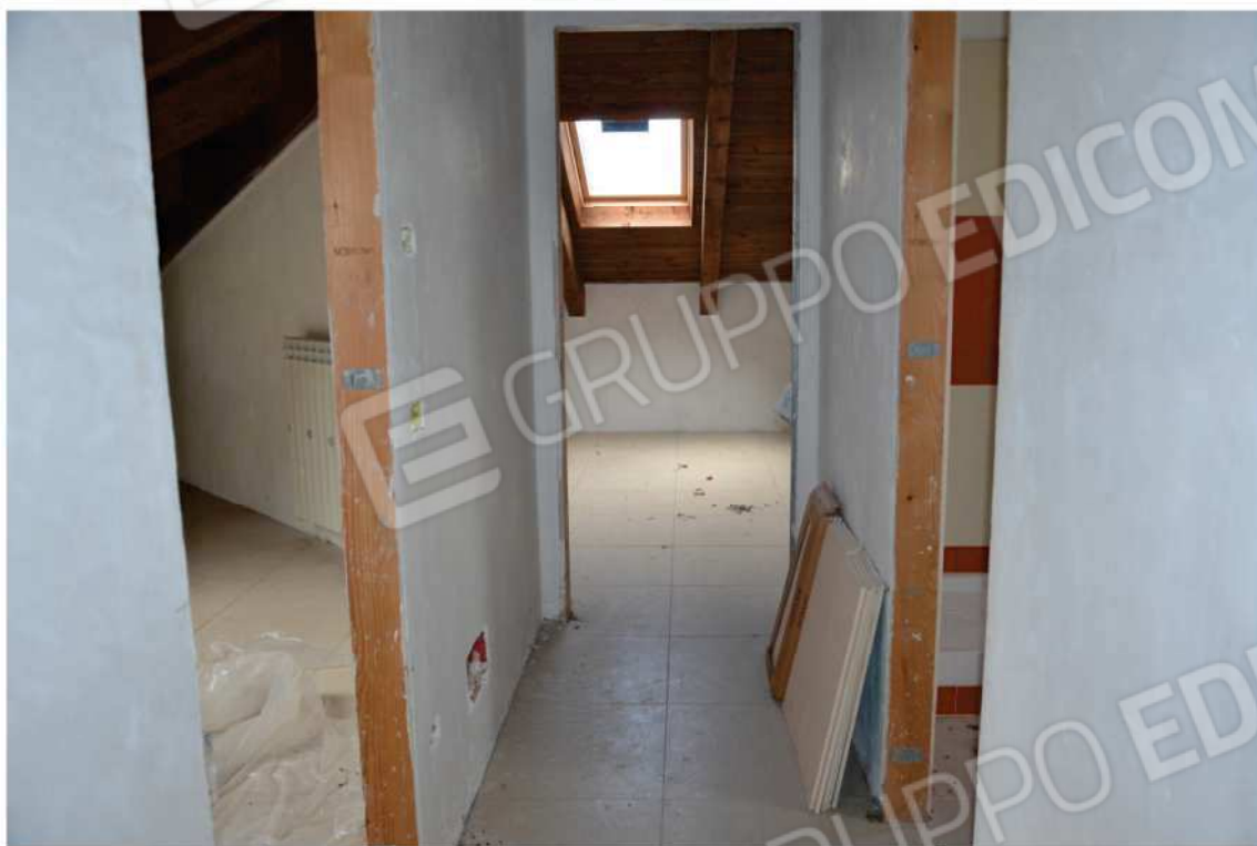
FOTO N. 13 Piano Secondo - Sottotetto
