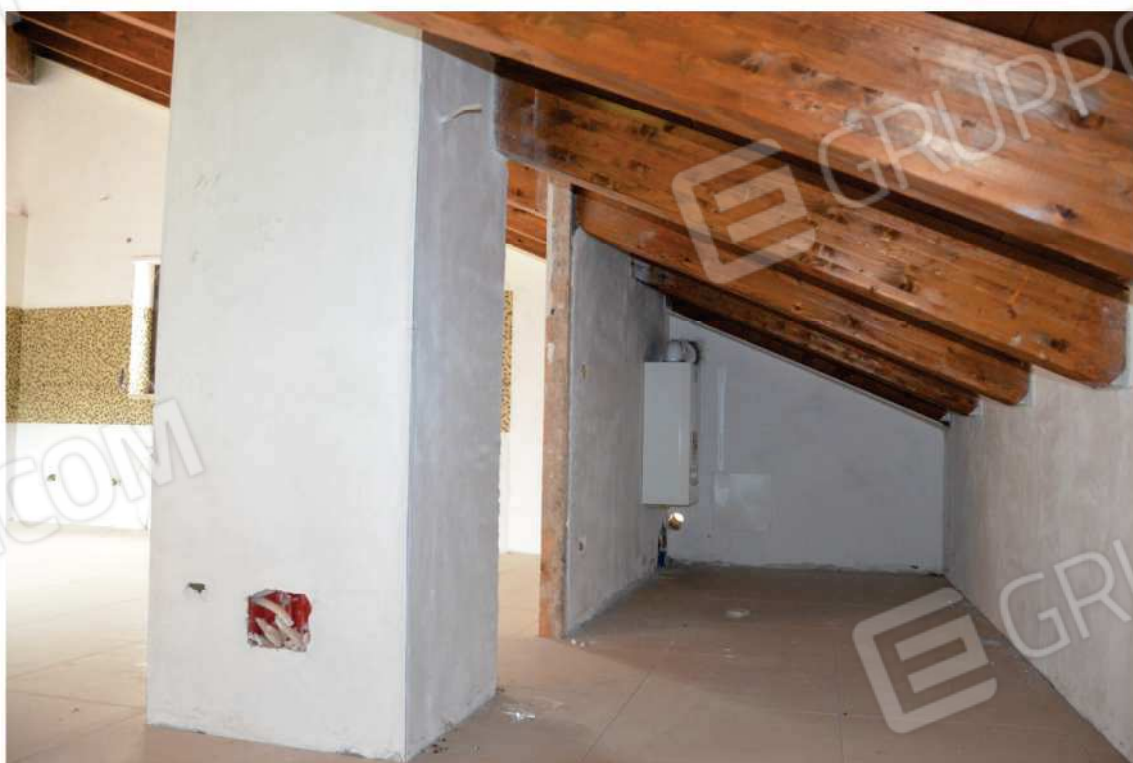
FOTO N. 10 Piano Secondo - Sottotetto
