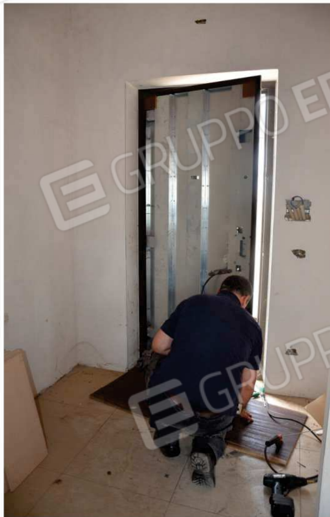
FOTO N. 7 Piano Secondo - Sottotetto Sostituzione serratura
