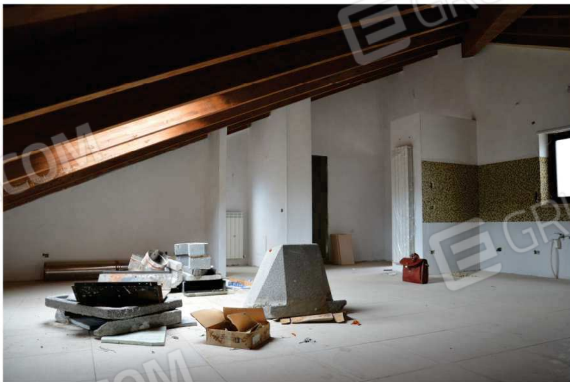
FOTO N. 8 Piano Secondo - Sottotetto
