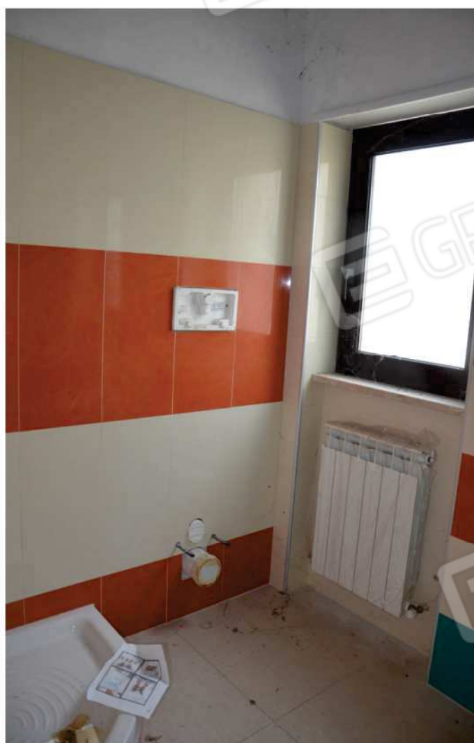
FOTO N. 14 Piano Secondo - Sottotetto
