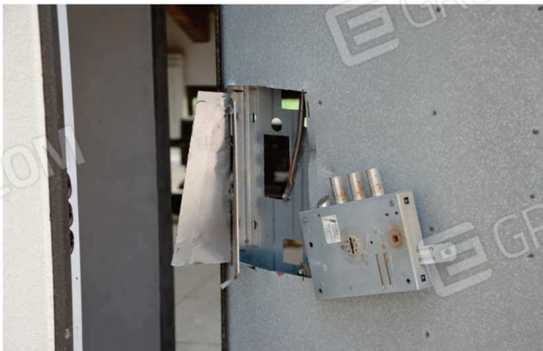
FOTO N. 6 Piano Secondo - Sottotetto Sostituzione serratura
