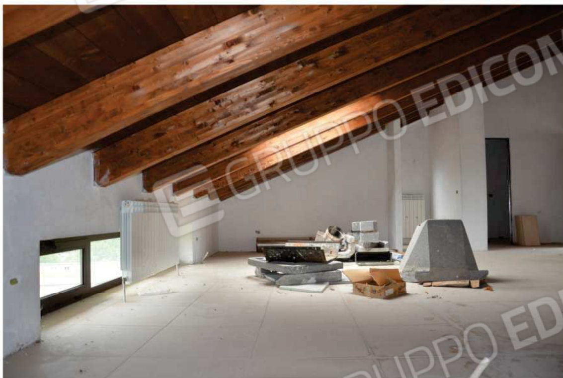
FOTO N. 11 Piano Secondo - Sottotetto
