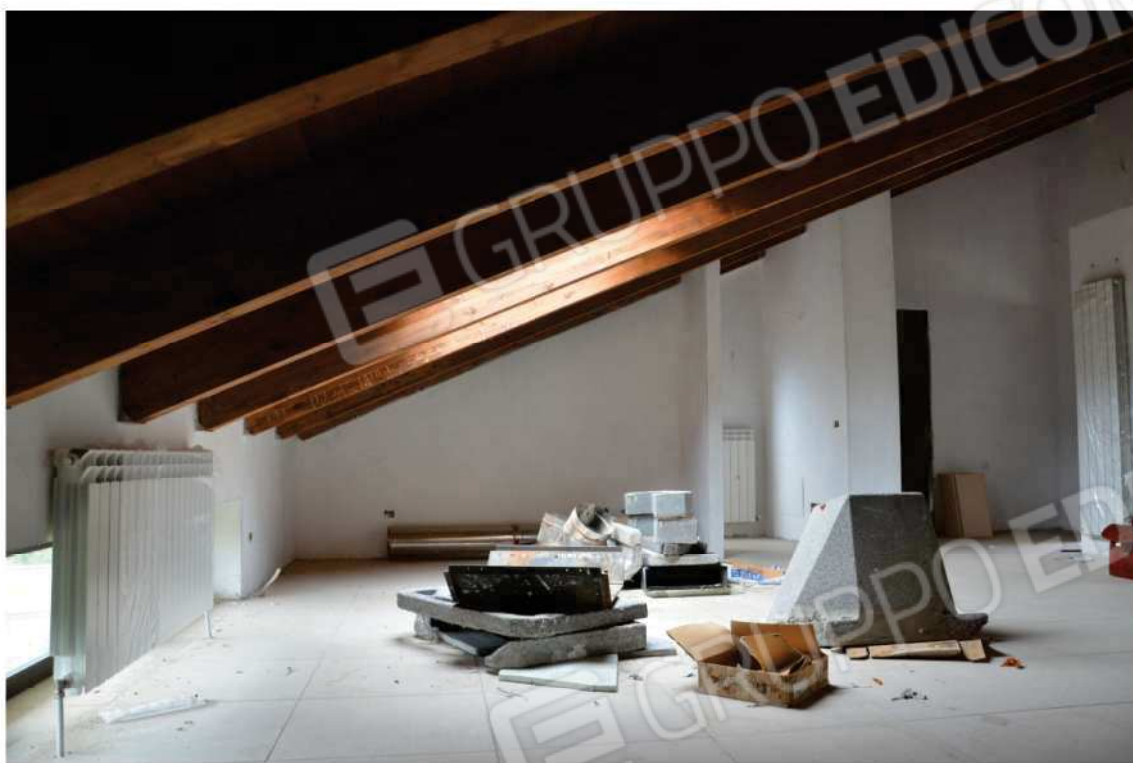
FOTO N. 9 Piano Secondo - Sottotetto
