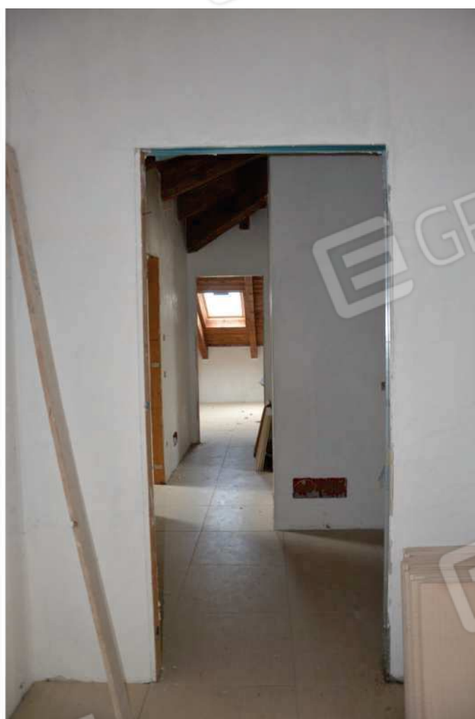
FOTO N. 12 Piano Secondo - Sottotetto
