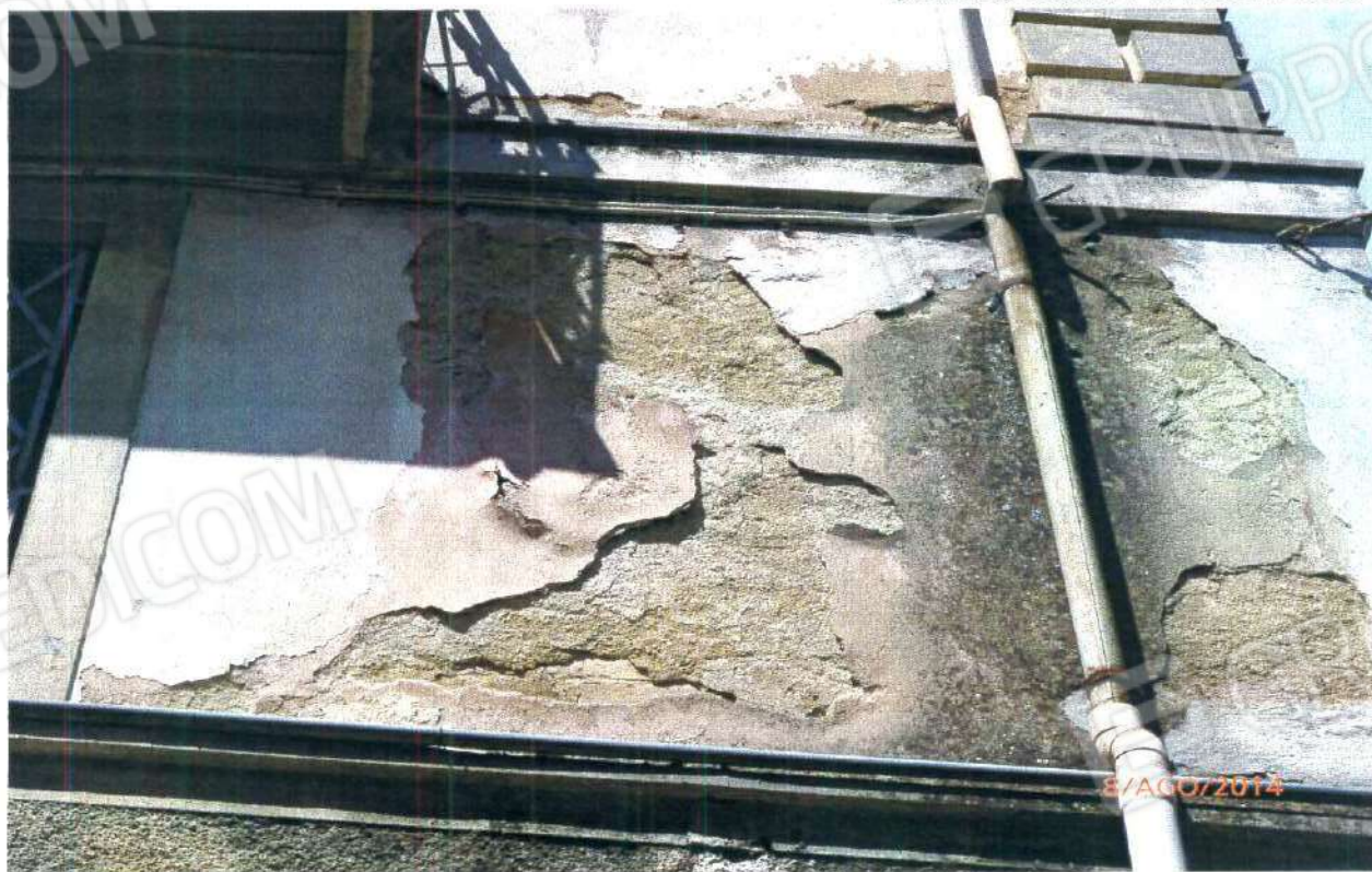
STATO DELL'INTONACO
