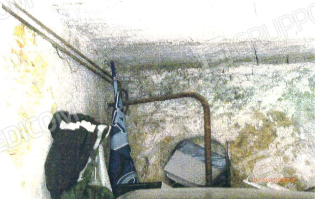
LOCALE CANTINA: INTERNO
